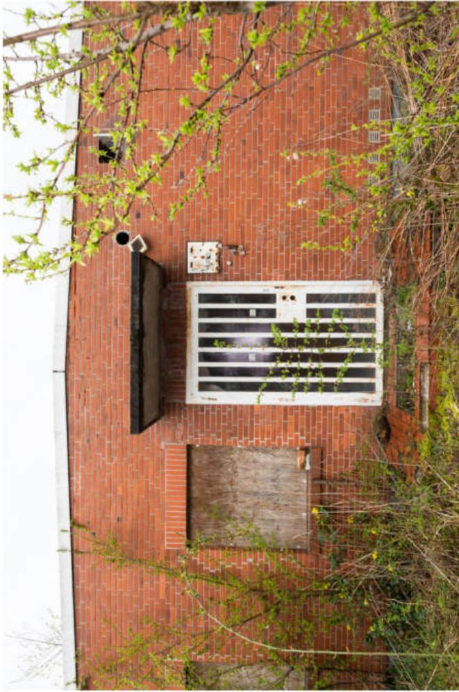
Alle Gebäude verfügen grundsätzlich über einen ebenerdigen Zugang, der sich im Moment allerdings trotzdem als Schwelle darstellt, da das umliegende Erdreich teilweise stark abgesunken ist.
