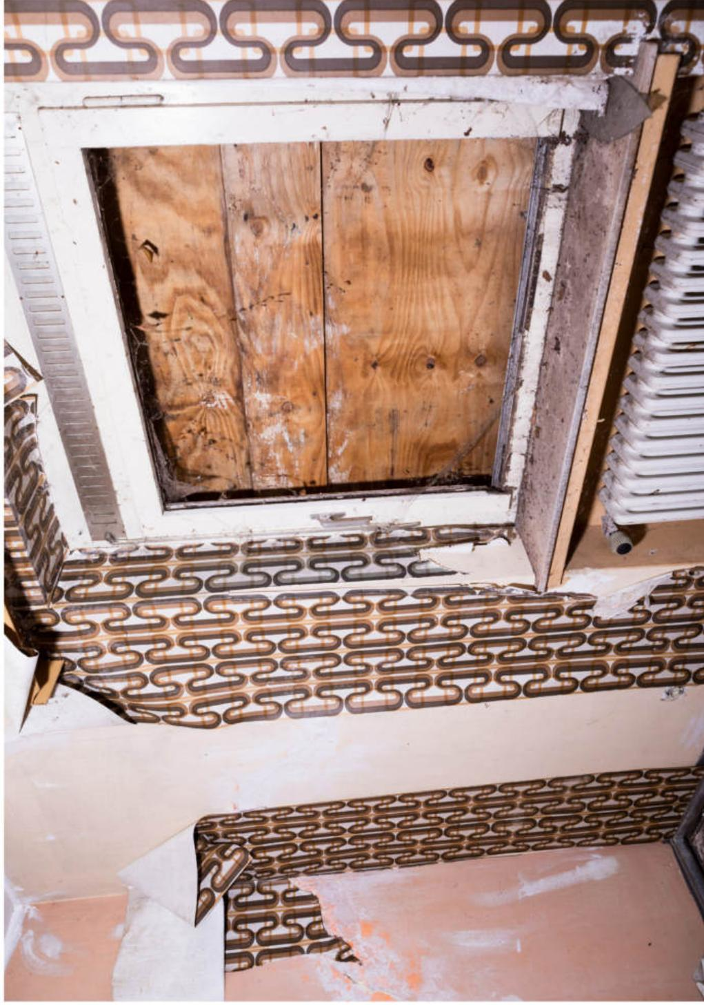
Feuchtigkeitsschäden sind zum großen Teil durch Nässe, die durch die Fenster oder andere Einbruchstellen in den Innenraum gelangt ist, entstanden.
