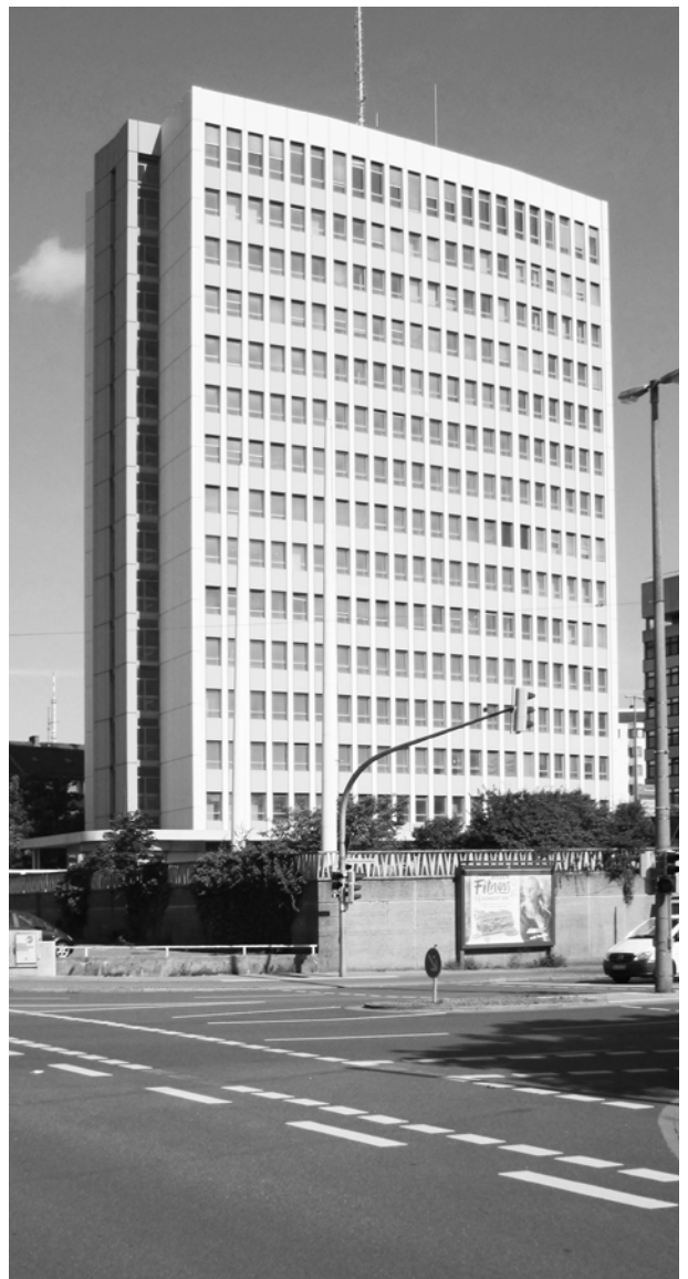
Abb. 86 Längsseite Bestand - Falkenstraße
