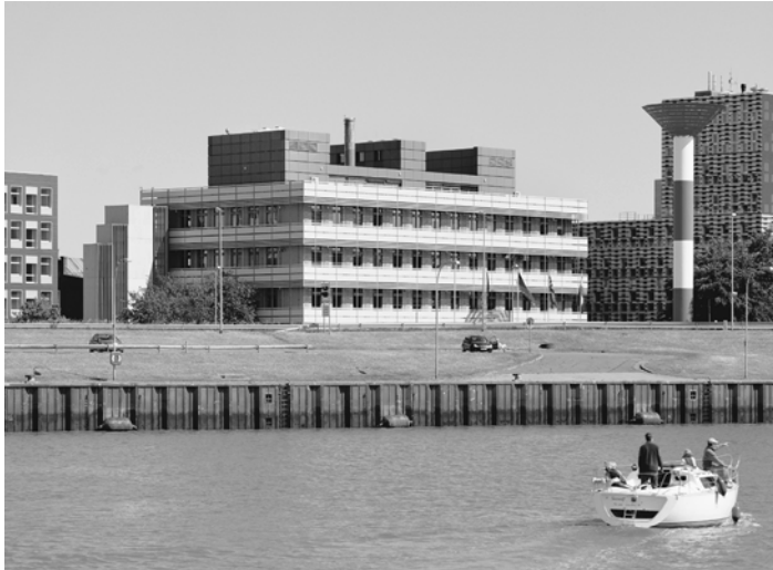
Abb. 17 AWI - Bremerhaven - vor der Revitalisierung
