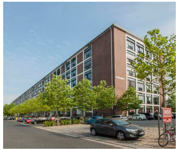
Abb. 11 Speicher I - Überseestadt
