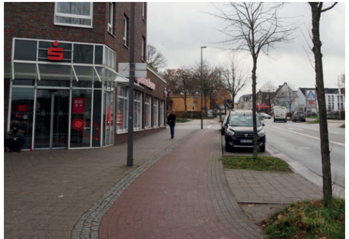
Abb. 40 Typische Straßenraumgestaltung in Bremen mit der „Hillmannplatte“ im Umfeld des Oslebshauer Bahnhof
