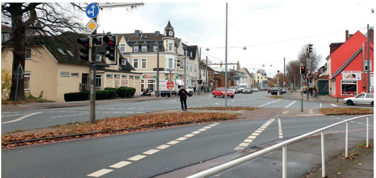
Abb. 9 Knotenpunkt Oslebshauer und Ritterhuder Heerstraße: der Knotenpunkt in die Straße Oslebshauer Landstraße ist verzogen. (Blick stadtauswärts)
