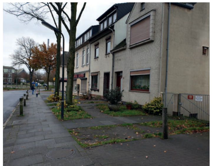
Abb. 29 Vorzone mit wenig Schutz für die sensible Wohnnutzung aufgrund vormaliger Geschäftslage Oslebshauer Landstraße
