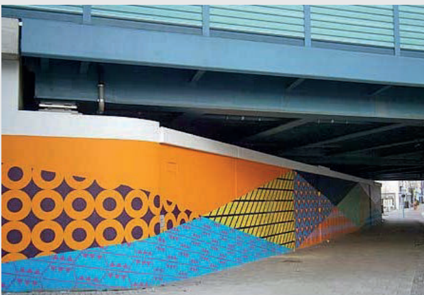
Bahnunterführung in der Schwachhauser Heerstraße, Bremen (Quelle: Joachim Kothe)
