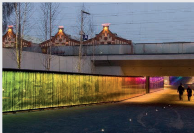
Bahnunterführung in Lingen (Quelle: Richard Heskamp)
