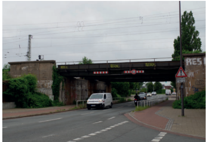
Abb. 41 Tunnelsituation am Oslebshuser Bahnhof
