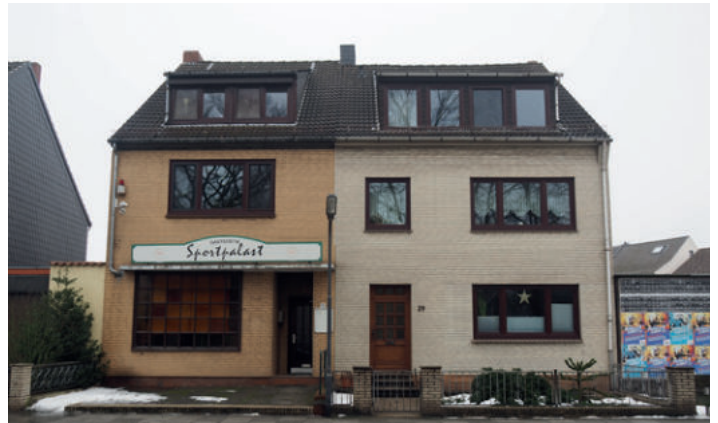
Abb. 49 Leerstand und energetischer Sanierungsbedarf
