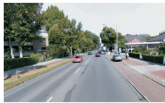
Straßenraum der Straße Kirchhuchtinger Landstraße als Beispiel für eine nach Verkehrsteilnehmern gegliederte Straße
