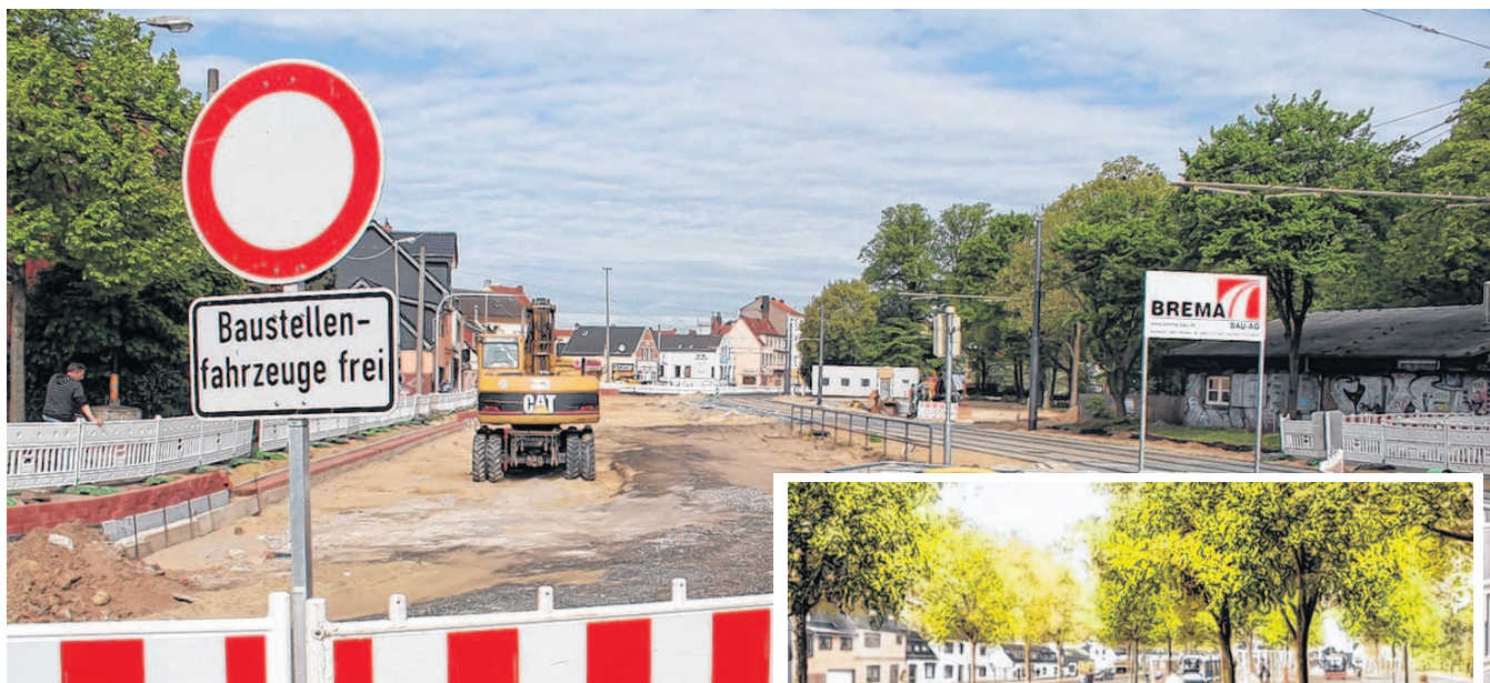
Eine große Sandkiste: Die Umsteigestelle Huckelriede befindet sich aktuell im Umbau. Gleich nebenan soll ein neuer Stadtplatz entstehen, das Spielhaus wird abgerissen. Foto: Thorben Müller
