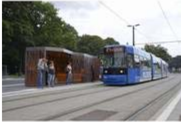
Der neue Fahrgastunterstand an der Haltestelle „Huckelriede“ ist von allen Seiten begehbar. Die Straßenbahn AG investierte in die Modernisierung der Anlagen, die auch eine Aufwertung des Bremer Stadtteils bedeutet. Foto Schnackenburg
