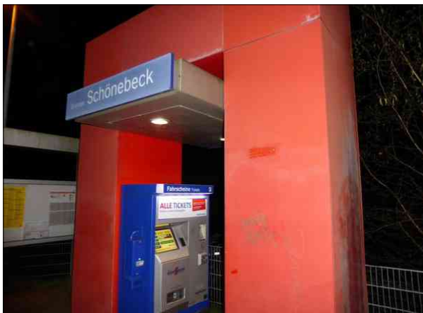
Abbildung 47: Das Bahnhofnamensschild im Pluspunkt an Gleis 2 in Bremen-Schönebeck war unbeleuchtet und daher bei Dunkelheit nicht lesbar.
