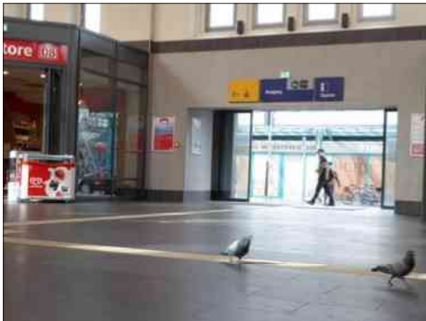
Abbildung 28: Im Gegensatz zum letzten Jahr wurden im Bahnhofsgebäude von Bremerhaven Hbf keine flächenhaften Verschmutzungen durch Taubenkot angetroffen. Die Vögel sind jedoch weiterhin präsent.
