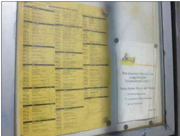
Abbildung 46: Die Scheibe der Vitrine am Zugang des Bahnsteigs in Bremerhaven-Wulsdorf ist stark zerkratzt.
