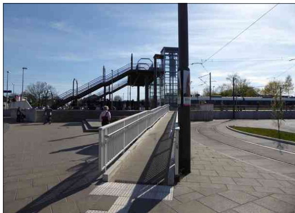
Abbildung 5: In Bremen-Mahndorf ist der Bahnsteig Richtung Bremen Hbf von der Straßenbahnhaltestelle über eine Rampe barrierefrei erreichbar.
