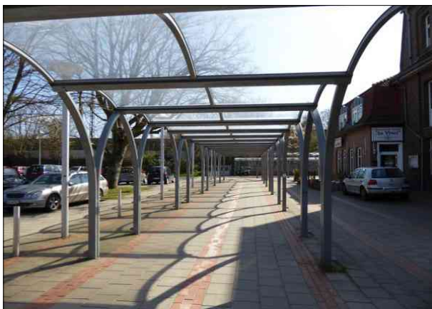
Abbildung 36: Während die Scheiben der Überdachung an der Zuwegung zum Bahnhof Bremerhaven-Lehe gereinigt waren, fielen einige neue Aufkleber an den Stützen auf.
