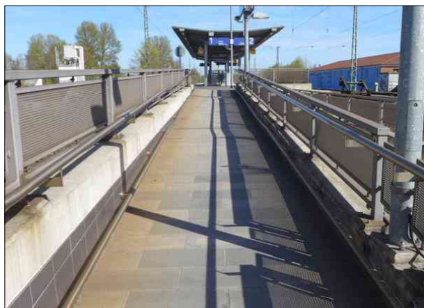
Abbildung 4: Der Bahnhof Bremen-Oslebshausen wurde vor einigen Jahren barrierefrei ausgebaut. Zwischen Unterführung und Bahnsteig wurde eine Rampe errichtet, die den Fahrgästen unabhängig von technischen Problemen (Aufzüge) jederzeit einen stufenlosen Zugang ermöglicht.
