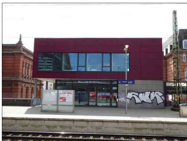
Abbildung 41: Die Fassade der Fahrradstation in Bremen Hbf an Gleis 1 war beschmiert.
