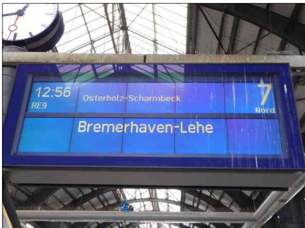
Abbildung 17: In Bremen Hbf waren einzelne Zugzielanzeiger durch Taubenkot verunreinigt.
