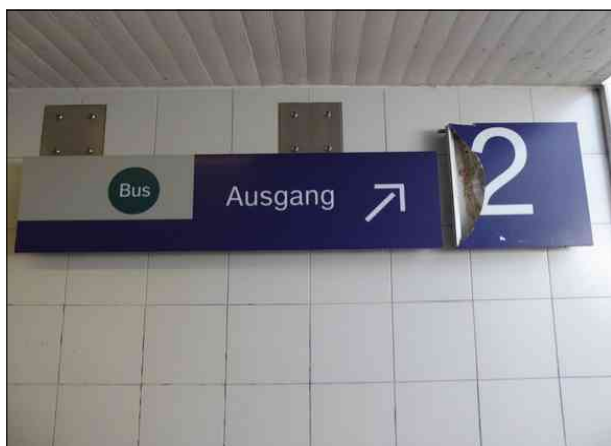
Abbildung 24: Der positive Effekt des Ersetzens fehlender Schilder im Bahnhof Bremen-Burg wurde durch neue kleine Schäden etwas getrübt.
