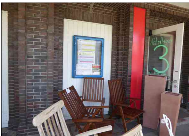
Abbildung 27: Vom neuen Nutzer des an die Bahnsteigzuwegung angrenzenden Gebäudeteils in Bremen-Neustadt wurde die Vitrine mit Fahrplanänderungen durch Ausstellungsstühle zugestellt.
