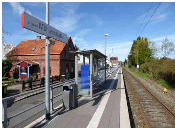
Abbildung 43: Einwandfrei waren der Bahnsteig, die Fahrgastunterstände und die Sitzgelegenheiten in Bremen Mühlenstraße.
