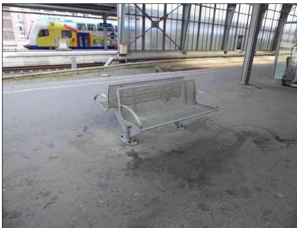
Abbildung 8: Die Bahnsteige in Bremen Hbf sind in den Bereichen von Sitzbänken stellenweise verschmutzt.
