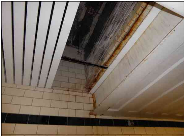
Abbildung 34: Im Bahnsteigtunnel von Bremerhaven Hbf wurden weitere Deckenverkleidungen an den undichten Gleiströgen entfernt.
