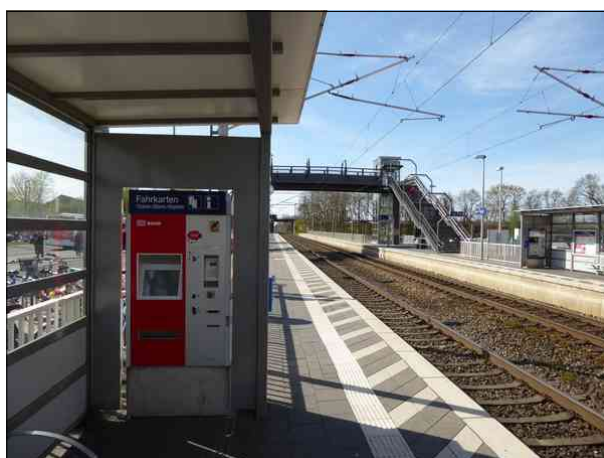
Abbildung 48: Durch eine den Fahrkartenautomat umschließende Verkleidung wurde der Wetterschutz in Bremen-Mahndorf an Gleis 1 deutlich verbessert.
