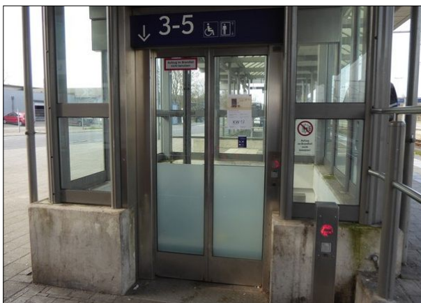
Abbildung 6: Der Aufzug am Hausbahnsteig in Bremen-Burg war am Tag der Erhebung außer Betrieb. Damit war eine barrierefreie Erreichbarkeit der Bahnsteige an den Gleisen 3, 4 und 5 nicht gegeben.
