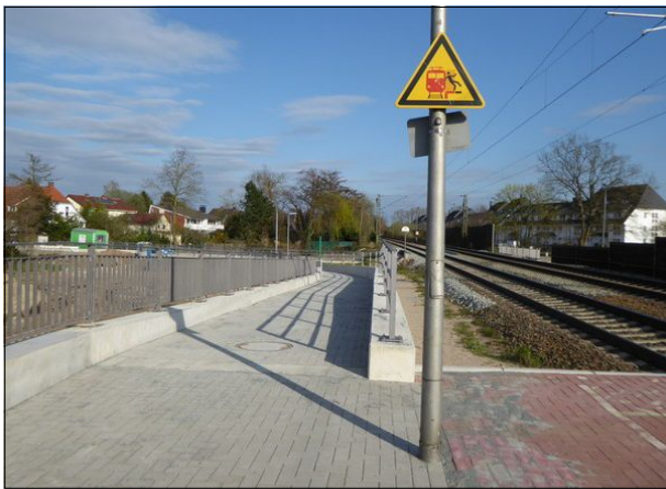
Abbildung 2: Nach Fertigstellung der Unterführung steht der östliche Zugang am Bahnhof Bremen-Oberneuland wieder zur Verfügung.
