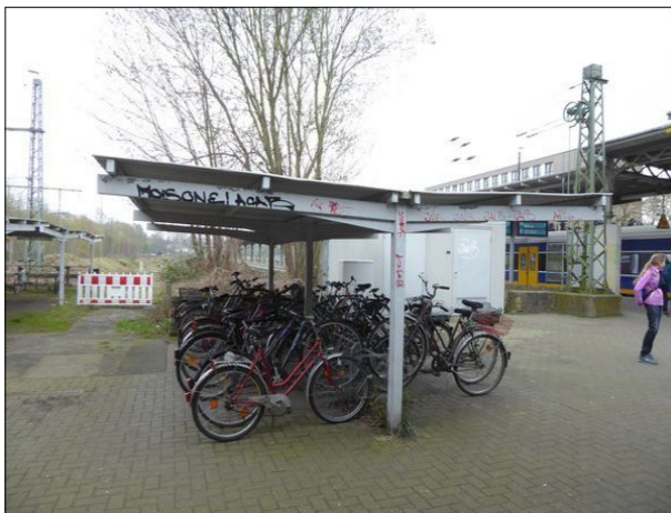
Abbildung 50: Die Fahrradabstellanlage am Bahnsteigzugang in Bremen-Vegesack ist nicht mehr zeitgemäß und beschmiert.
