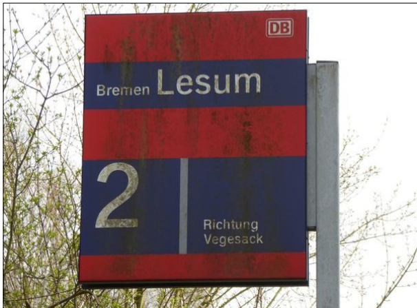
Abbildung 23: Besonders die Schilder an den Stationsmasten in Bremen-Lesum waren stark verschmutzt.
