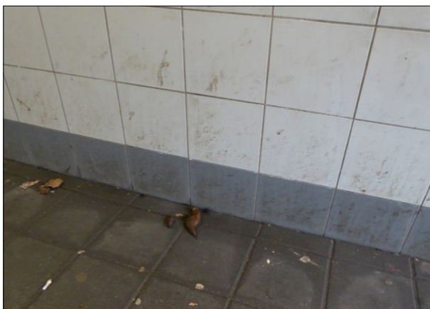
Abbildung 36: Der Bahnsteigtunnel in Bremerhaven-Lehe war unter anderem durch Exkremente verschmutzt.
