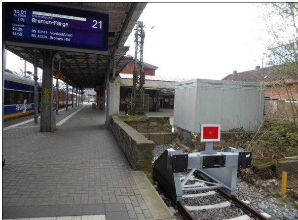
Abbildung 43: Im Zusammenhang mit der Erneuerung des Prellbocks an Gleis 21 in Bremen-Vegesack wurde das dahinterliegende Beet entfernt. Dieses wurde oft zur Müllentsorgung missbraucht.
