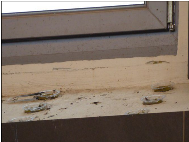
Abbildung 28: Im Bahnhofsgebäude und im Tunnel des Bremerhavener Hauptbahnhofs sollen Tauben durch Gerüche einer Paste, die in kleinen Schälchen platziert wird, vergrämt werden.
