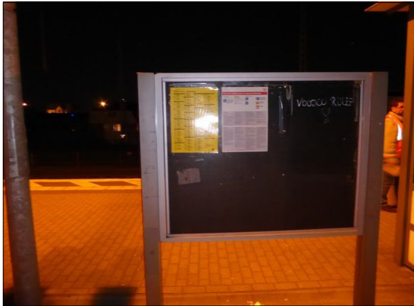
Abbildung 25: Die Tafel zum Anbringen der wichtigsten Informationen auf dem Bahnsteig in Bremen-Walle war neben den Aushängen verschmutzt. Die ungenutzte Rückseite war beschmiert. Die beiden Aushänge sind relativ klein.
