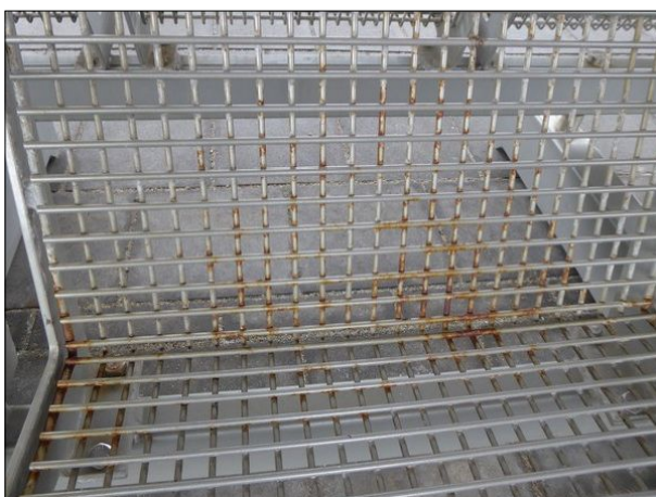
Abbildung 45: Einige Sitze auf den Bahnsteigen im Hauptbahnhof von Bremerhaven sind angerostet.
