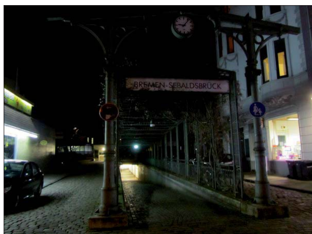
Abbildung 35: An der Rampe aus dem Bahnhofstunnel zur Sebaldsbrücker Heerstraße funktionierte in Bremen-Sebaldsbrück nur eine Lampe.
