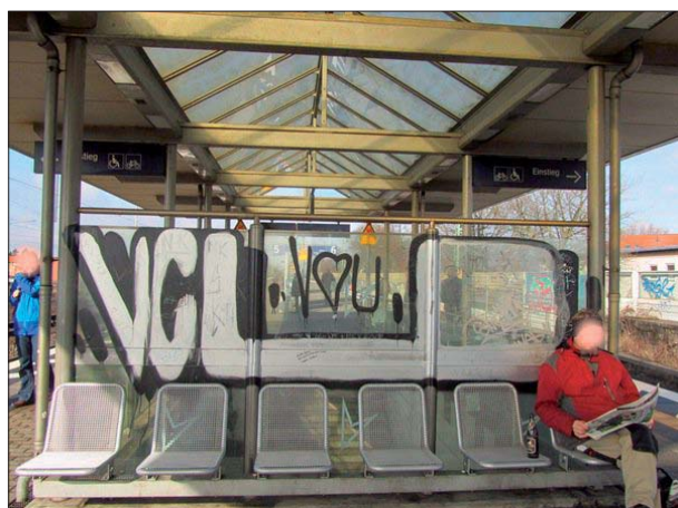
Abbildung 8: Auch das Erscheinungsbild dieses Wartebereichs in Bremen-Walle war durch ein Graffiti auf der Glaswand beeinträchtigt.
