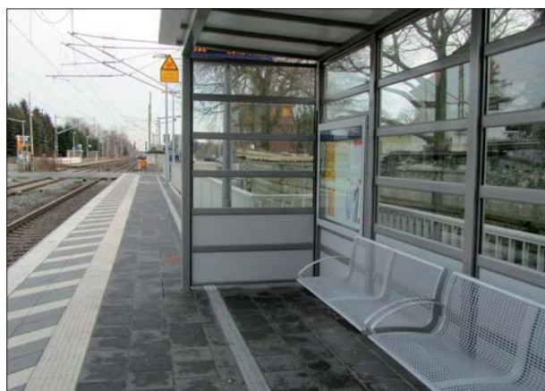
Abbildung 13: Zu nah an den Fahrgastunterständen platziert wurde je Bahnsteig ein Dynamischer Schriftanzeiger in Bremen-Mahndorf. Die Anzeigen sind aus dem Unterstand heraus somit nicht zu erkennen.
