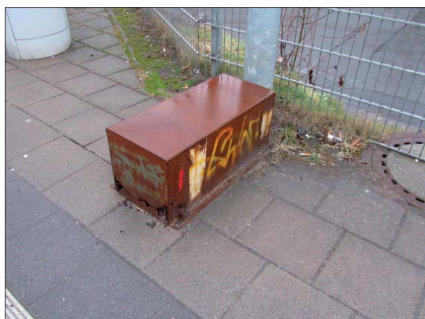
Abbildung 42: Ohne erkennbare Funktion stehen auf den Bahnsteigen in Bremen-Schönebeck diese verrosteten Sockel, die zudem eine Stolperfalle darstellen.
