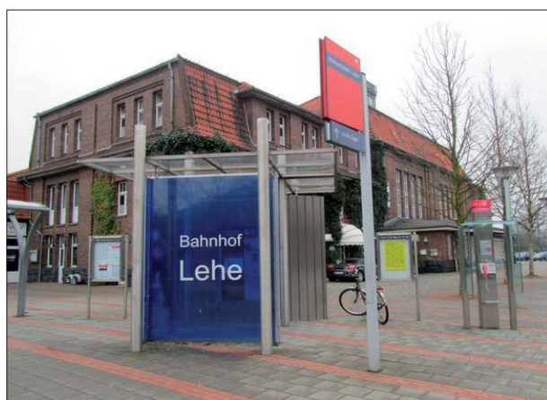
Abbildung 21: Durch seine individuelle Kennzeichnung fällt der Zugangsbereich auf dem Bahnhofsvorplatz in Bremerhaven-Lehe positiv auf.
