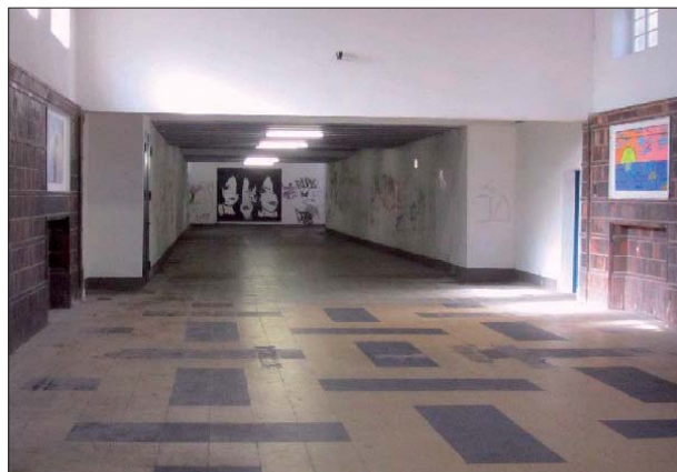
Abbildung 48: Während ein Schulprojekt aus dem Jahr 2008 in der Empfangshalle des Bahnhofs Bremen-Neustadt noch Wirkung zeigt, ist der anschließende Bahnsteigtunnel völlig beschmiert.
