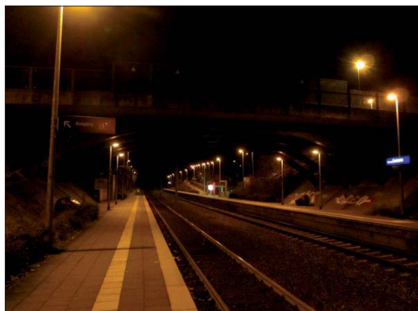
Abbildung 34: Die Bahnsteigbeleuchtung in Bremen-Lesum funktionierte einwandfrei. Zu erkennen ist aber auch ein nicht beleuchtetes Ausgangsschild.
