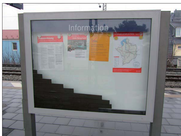
Abbildung 3: Diese beschädigte Vitrine in Bremen-Oslebshausen war provisorisch repariert.
