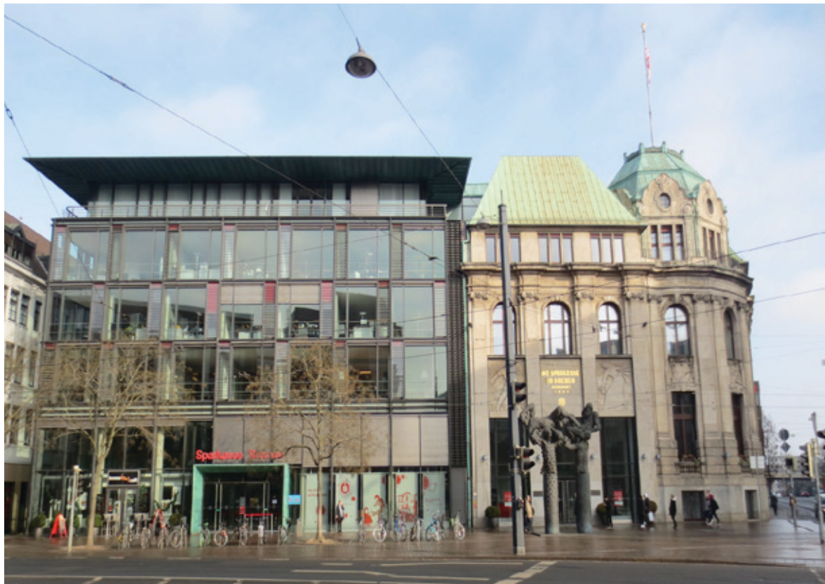
Kernbau der Sparkasse und Anbau mit Haupteingang
