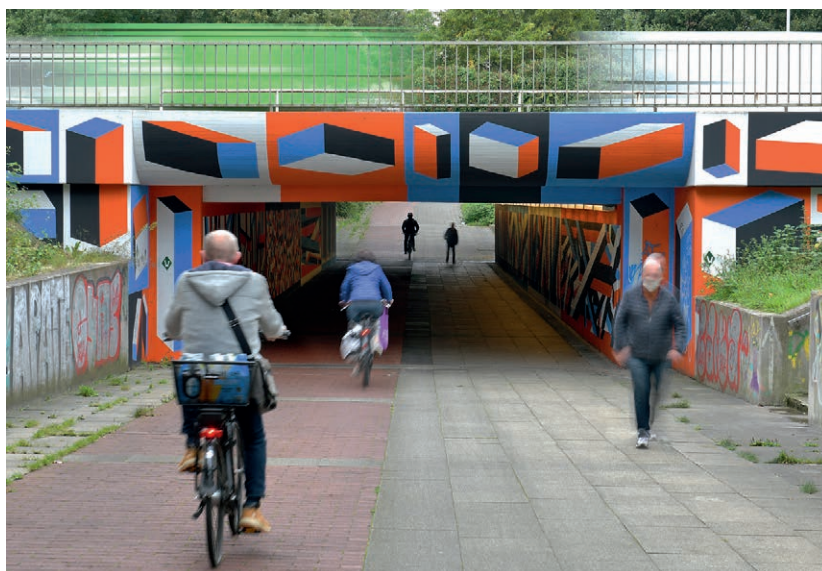
Foto 4: Meta-Sattler-Tunnel unter der Utbremer Straße
