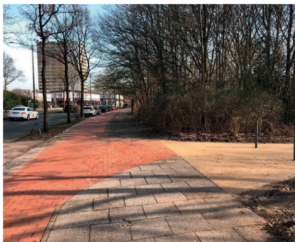
Fotos 42/43: Einmündung Wegeverbindung am Osterholzer Friedhof: Vorher: schmal und roter Betonstein, nachher: beige eingefärbter Asphalt
