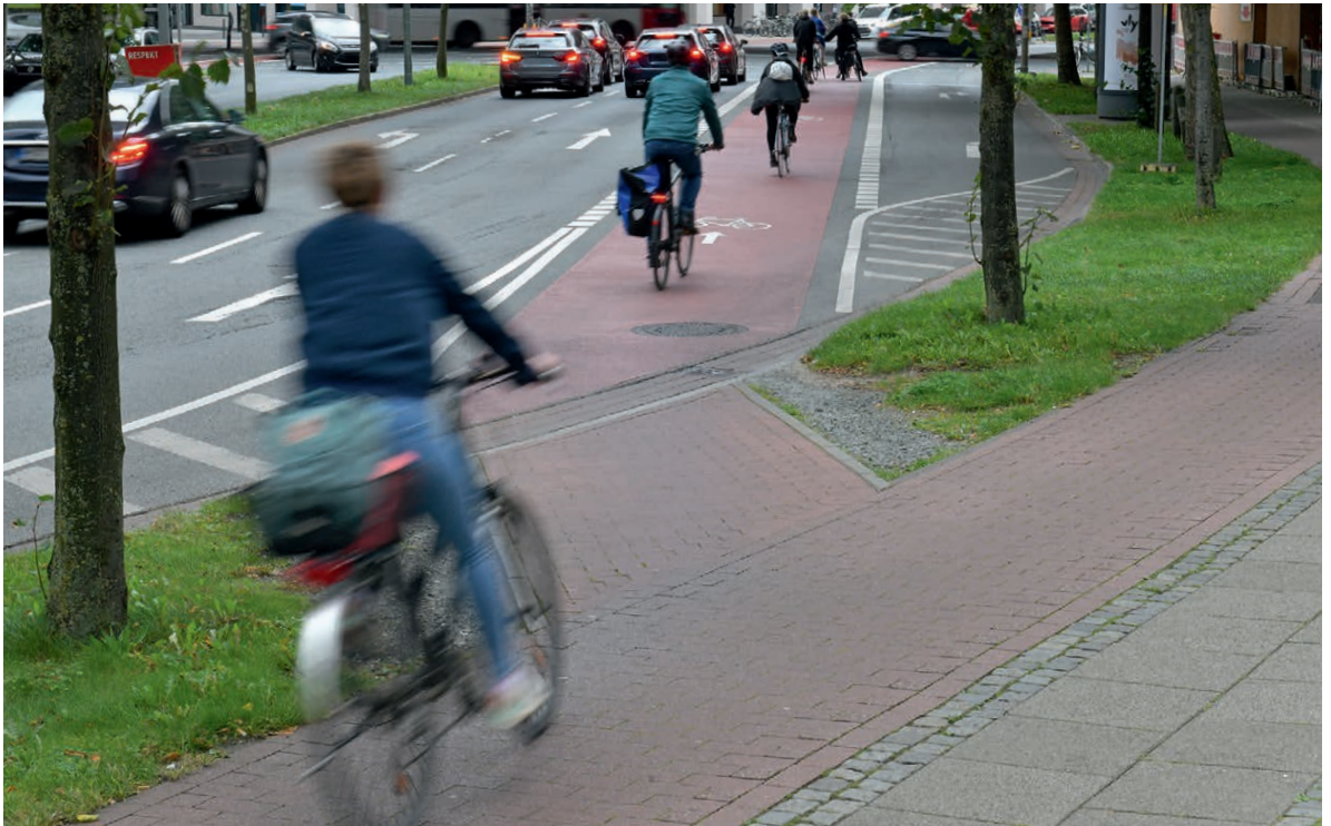
Foto 40: Umbau und Markierungs-lösungen am Herdentorsteinweg
