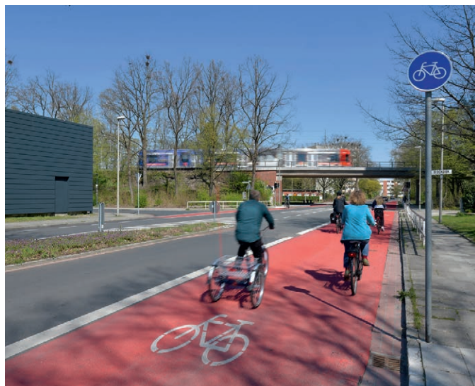
Foto 46: Flächig eingefärbter extrabreiter Radfahrstreifen statt Kfz-Fahrstreifen
