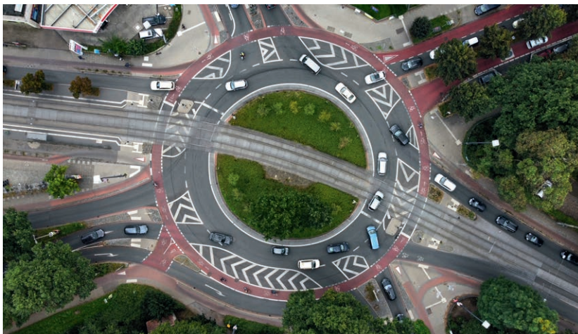
Foto 7: Kreisverkehr Am Stern aus der Luft
