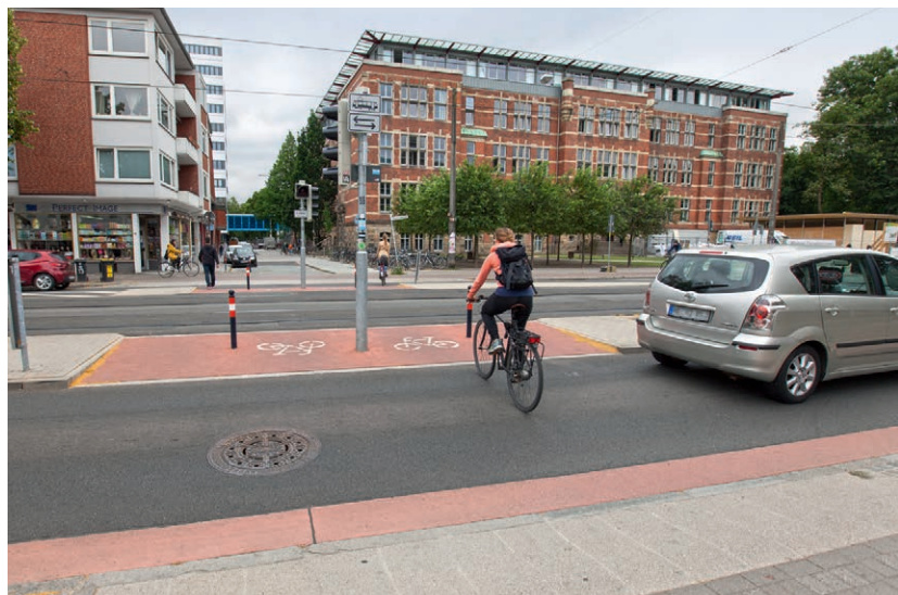
Foto 44: Querung Langemarckstraße – freie Querung der Fahrbahn, Signalisierung der Straßenbahngleise
