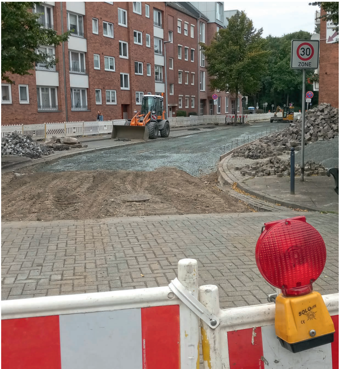
Foto 53: Faulenstraße wird Fahrradstraße mit neuem Belag
