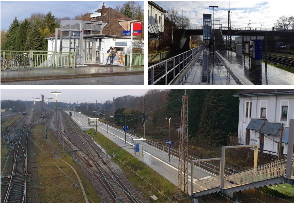
Abb. 13: Fotos der modernisierten Verkehrsstation Bremerhaven-Wulsdorf (Dezember 2020) [Quelle: DB Station&Service AG; SKUMS]
