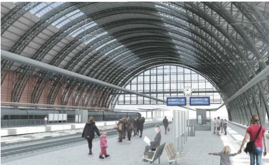
Abb. 19: Visualisierung der Vorzugsvariante zur Erneuerung der Gleishallen mit Oberlichtern im Bremer Hauptbahnhof [Quelle: DB Station&Service AG]
