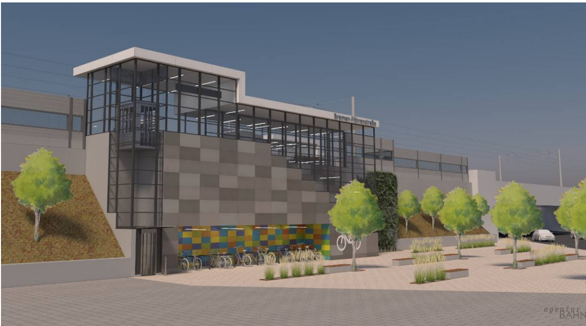
Abb. 15: Transparente Gestaltung der Zugangsbauwerke an der neuen Station Bremen-Föhrenstraße (oben) [Quelle: Agentur BahnStadt]
