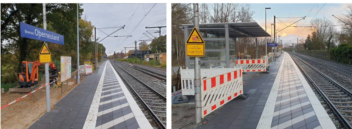
Abb. 14: Fotos der Bauarbeiten an der Verkehrsstation Bremen-Oberneuland (Oktober 2020 & Januar 2021) [Quelle: SKUMS]
