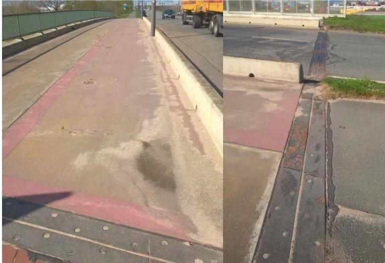
Die anstehenden Instandsetzungs- bzw. Erneuerungsarbeiten umfassen eine Teilerneuerung der vorhandenen Übergangskonstruktionen, die Erneuerung des Asphaltbelages sowie die Instandsetzung des Kappenbetons der südlichen Geh- und Radweg-Kappe. Hier ist im Hinblick auf die Kappenentwässerung eine Reprofilierung des Kappenbetons unbedingt erforderlich, da das Wasser aktuell nicht durch die dafür vorgesehenen Öffnungen in der Stahlbeton - Aufkantung abfließen kann.
