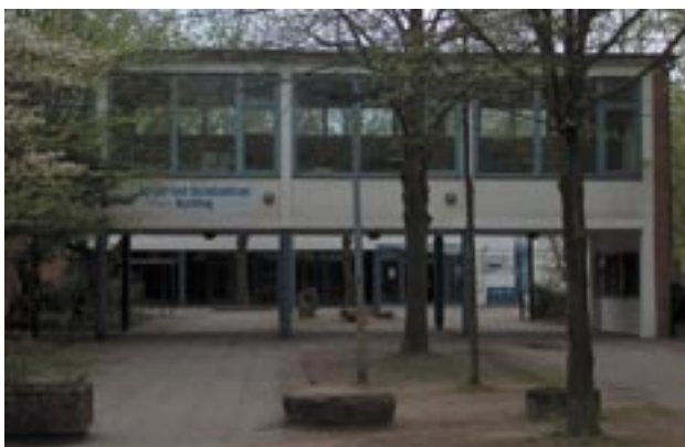
Foto 7: BUS - Bürger- und Sozialzentrum in Sodenmatt
