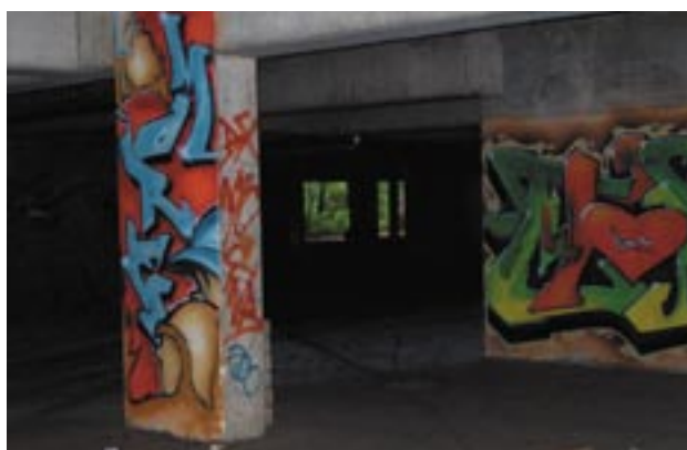
Foto 6: Schulzentrum Delfter Straße, Tiefgarage
