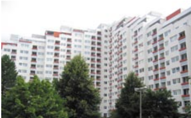
Foto 1: Saniertes Hochhaus in Tenever
