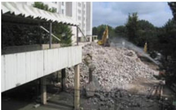
Foto 5: Abbrucharbeiten in Tenever
