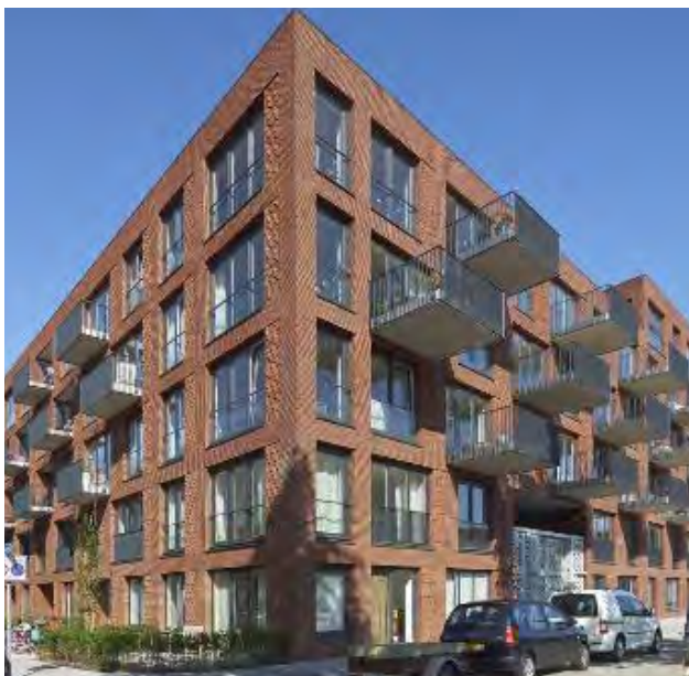
Abb. 57: Ruhiges Fassadenraster mit Akzenten durch verspringende Balkone, Gleichbehandlung beider Fassaden bei einer Eckausbildung.
