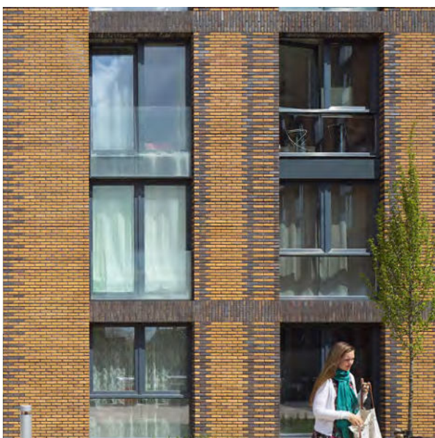
Abb. 31: Beispiel Ziegelmauerwerk - Durch verschiedene Steinfarben werden unterschiedliche Muster hergestellt. Diese sollen, wenn möglich, die Vertikalität der Fassade unterstützen.
