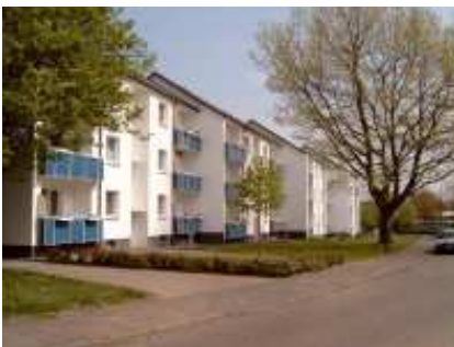
Modernisierte Geschosswohnungsgebäude an der Lehmhorster Straße im Quartier Lüssum-Bockhorn Mitte
