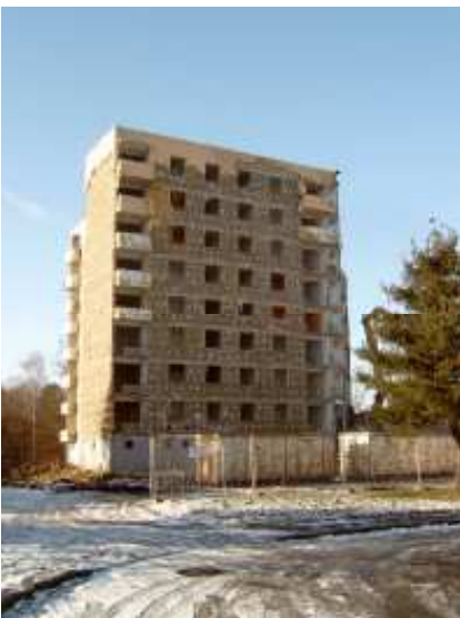
Wohnungsrückbau im Wohnquartier Lüssumer Ring
