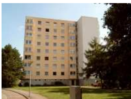
Achtgeschossiges Punkthochhaus am Lüssumer Ring, auf Grund der schwierigen Vermietungssituation fand hier bereits ein Rückbau statt
