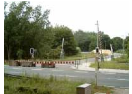
Im Bau befindliche neue Erschließung des Gewerbe- und Industriegebietes Vulkan-West
