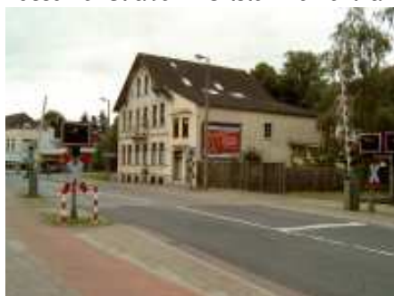
Bahnübergang über die Trasse der Farge-Vegesacker-Eisenbahn an der Lüssumer Straße im Ortsteil Blumenthal
