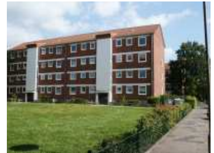
Wohnzeile am Lüssumer Ring in baulichem gutem Zustand (Quartier Lüssum-Bockhorn West)
