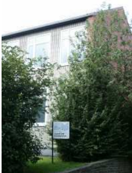
Schule an der Admiralstraße mit Schulbibliothek
