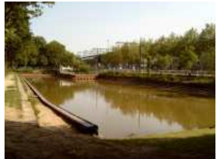
Torfhafen mit Messehallen im Hintergrund während der Umbauphase
