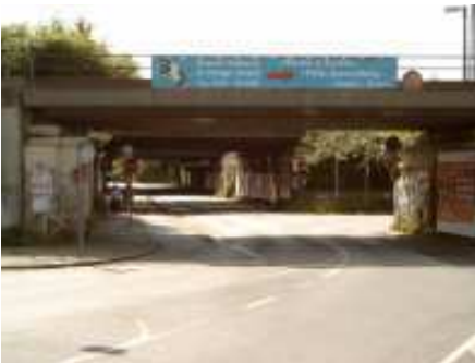
Einseitige Fuß- und Radwegführung im Tunnel Münchener Straße
