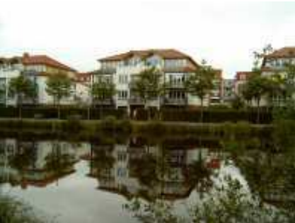
Attraktiver Wohnraum im Geschosswohnungsbau am Fleet im Wohngebiet Weidedamm III
