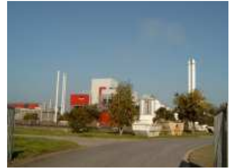
Müllheizwerk der ANO im Ortsteil In den Hufen
