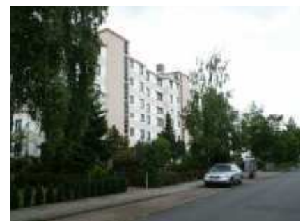
Geschosswohnungsbau an der Kissinger Straße im Ortsteil Weidedamm
