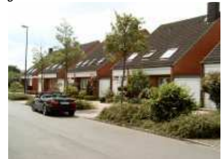
Einfamilienhäuser der 1970er Jahre an der Stuttgarter Straße im Wohngebiet Weidedamm II
