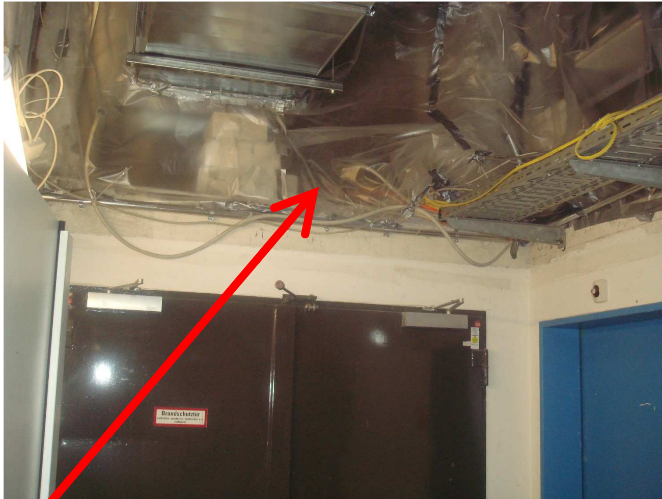
Brandwand oberhalb einer T90-Tür in einem Hochhaus (Vollbetrieb) bei der Brandschutzsanierung
