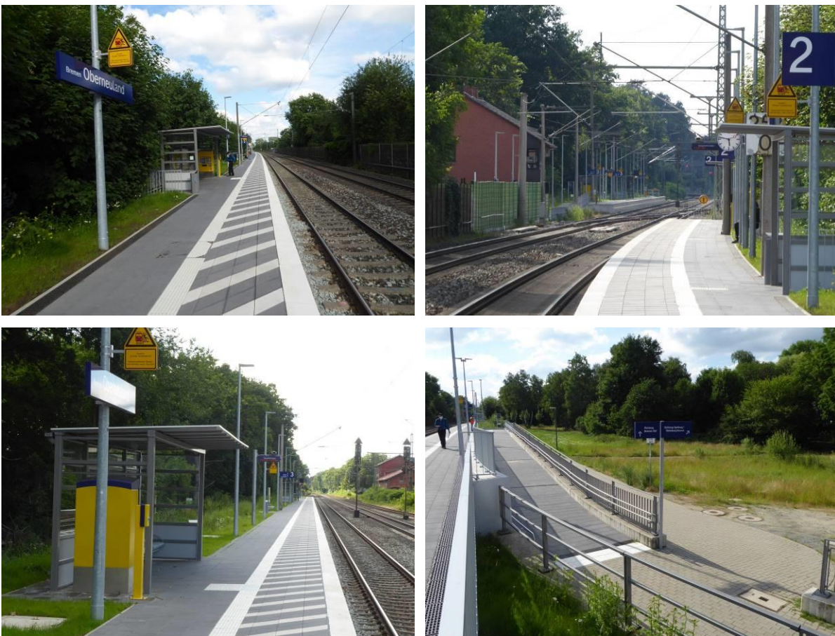
Abb. 16: Fotos der modernisierten Verkehrsstation Bremen-Oberneuland (Juli 2021) [Quelle: Agentur Bahnstadt]
