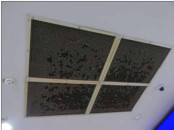
Abbildung 29: Im Seitenflügel vor dem Reisezentrum des Hauptbahnhofs in Bremen war das Lüftungsgitter an der Decke verschmutzt.
