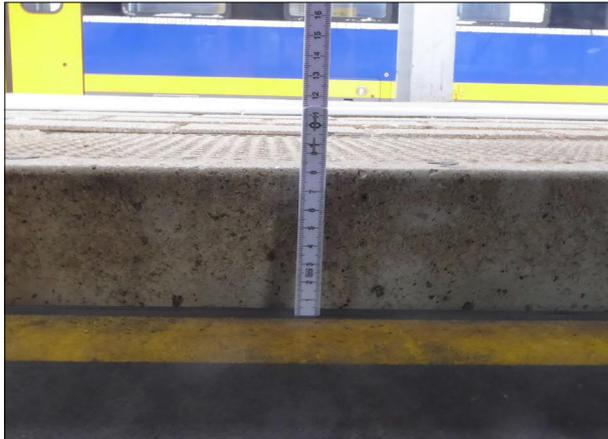
Abbildung 4: Ganz stufenlos geht es selten vom Zug auf den Bahnsteig. Eine Stufenhöhe von 8 cm, wie hier beim Halt einer Regio-S-Bahn in Bremen-Vegesack, ist ein Extremfall. Das Aussteigen für Rollstuhlfahrende ist dann jedoch ohne Hilfe kaum möglich.
