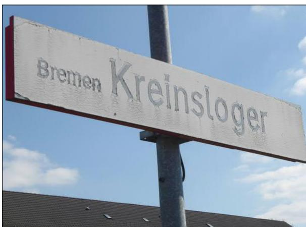
Abbildung 21: An einigen Bahnhofnamensschildern im Bereich der FVE blättern die Beschriftungsfolien ab. Auch der Kontrast zwischen Schrift und Hintergrund nimmt ab.
