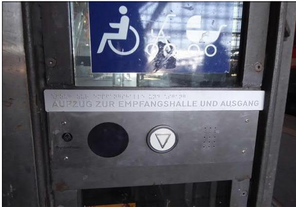
Abbildung 22: An den Aufzugseingängen in Bremen Hbf wurden zur Verbesserung der Orientierung für Sehbehinderte über den Bedientasten taktile Schrifthinweise befestigt.
