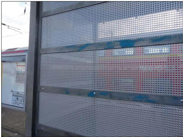
Abbildung 11: Um mutwillige Zerstörungen einzudämmen, wurden einige Scheiben des Fahrgastunterstands in Bremen-Walle mit Lochblech verkleidet.
