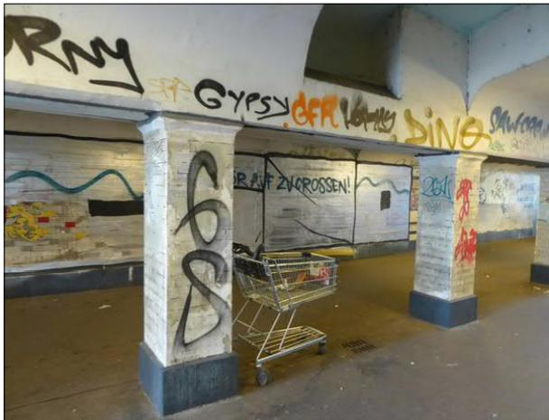
Abbildung 35: Das Erscheinungsbild der Fußgängerunterführung am Bahnhof Bremen-Sebaldsbrück wird durch Schmierereien und Verschmutzungen zunehmend schlechter. An einzelnen Stellen tropft wieder Wasser aus der Tunneldecke.
