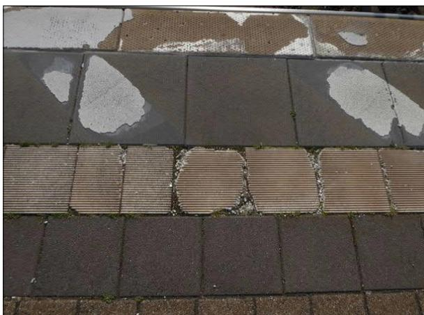
Abbildung 45: Die Platten des Blindenleitstreifens und die Gefahrenbereichsmarkierung auf dem Bahnsteig in Bremen-Walle sind bereichsweise beschädigt.
