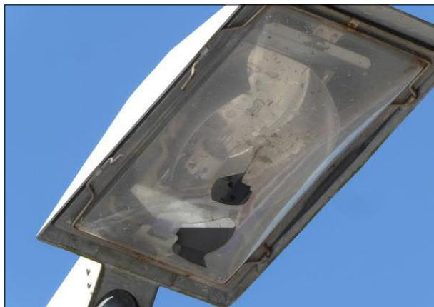
Abbildung 39: In Bremerhaven-Lehe waren neben einzelnen Dachleuchten auch zwei Hauben an Lichtmasten der Bahnsteigbeleuchtung beschädigt.
