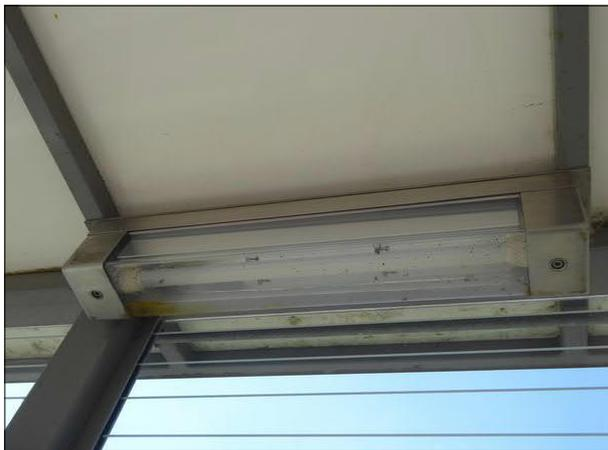
Abbildung 44: Diese Leuchte eines Unterstands in Bremen Turnerstraße war innen mit Insekten verschmutzt. Außerdem hatte sich in der Leuchtenhaube etwas Wasser gesammelt.
