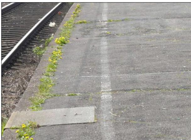
Abbildung 9: Der Bahnsteig in Bremen-Neustadt weist auf ganzer Länge und Breite Oberflächenschäden auf. Zudem gibt es stellenweise kleine Schäden an den Bahnsteigkanten.
