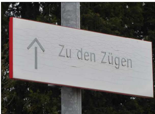
Abbildung 23: An einigen Schildern an den Stationen im Bereich der FVE sind Alterungserscheinungen in Form von abblättrender Beschriftungsfolie zu erkennen. Auch bei dem abgebildeten Schild am Haltepunkt Bremen Kreinsloger ist das der Fall.
