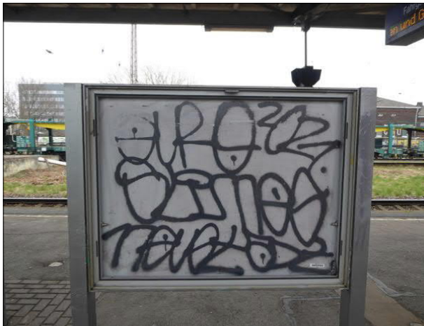
Abbildung 26: Die Scheibe der einzigen Vitrine auf dem Bahnsteig in Bremen-Neustadt fehlte, und die Rückwand war beschmiert. Informationsaushänge gab es nur am Bahnhofseingang.
