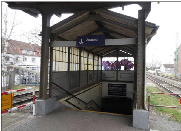
Abbildung 5: Diese Treppe in die gleisquerende Fußgänger:innenunterführung ist der einzige Zugang zum Bahnsteig in Bremen-Sebaldsbrück.
