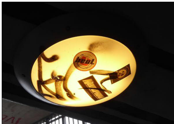
Abbildung 39: In der Unterführung am Bahnhof Bremen-Sebaldsbrück sind einige Leuchten bekrizelt und beklebt.
