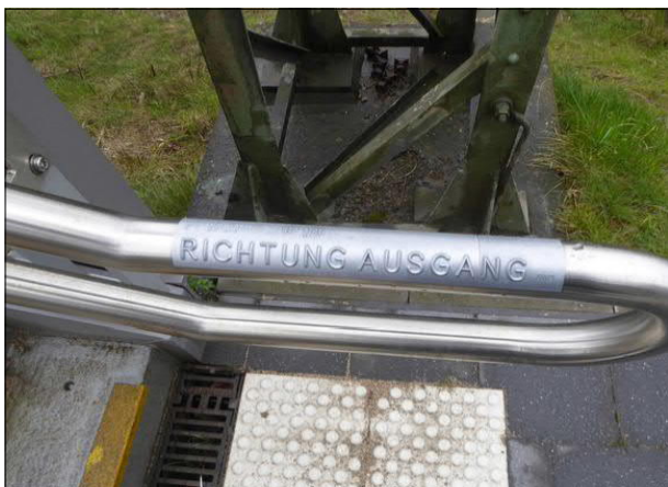
Abbildung 24: An vielen Handläufen der Rampen und Treppen zu den Bahnsteigen wurden taktile Wegweiserschilder für Sehbehinderte nachgerüstet. Auch an der Bahnsteigtreppe in Bremerhaven-Wulsdorf gibt es solche Schilder jetzt.
