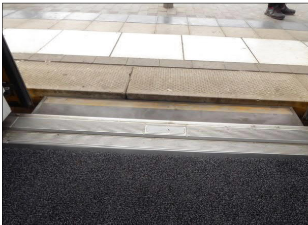
Abbildung 4: Ganz stufenlos geht es selten vom Zug auf den Bahnsteig. Bei einer Stufenhöhe von 3 cm wie hier beim Halt einer Regio-S-Bahn in Bremen-Burg ist das Ein- und Aussteigen für Rollstuhlfahrende problemlos möglich.
