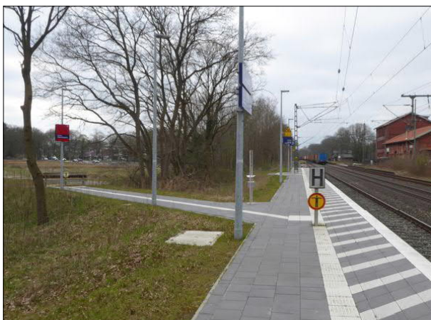
Abbildung 9: In Bremen-Oberneuland stand an Gleis 3 noch nicht die gesamte Bahnsteiglänge zur Verfügung. Auf dem Blindenleitstreifen wurde für Fahrten Richtung Bremen Hbf eine H-Tafel kombiniert mit einem Sperrschild platziert.
