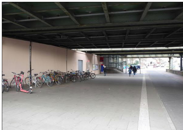
Abbildung 42: Durch den Farbanstrich der Wände wurde das Erscheinungsbild des Zugangsbereichs am Bahnhof Bremen-Walle unter den Eisenbahnbrücken verbessert.
