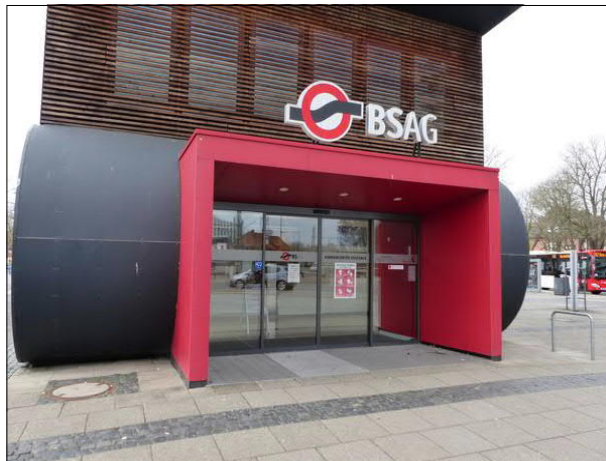
Abbildung 32: In Bremen-Vegesack wurde der personenbediente Fahrkartenverkauf von der BSAG mit ihrer Verkaufsstelle auf dem Bahnhofsvorplatz übernommen.
