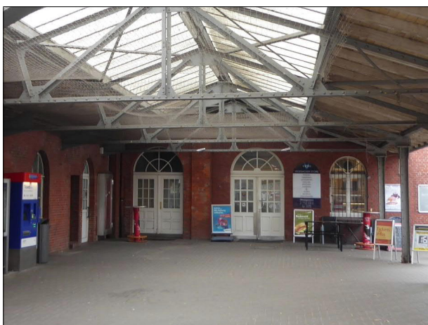
Abbildung 30: Nach der Schließung des Reisezentrums in Bremen-Vegesack verbleibt der Verkauf von Reisebedarf einschließlich von Fahrkarten des VBN-Tarifs die einzige öffentliche Nutzung im Bahnhofsgebäude.
