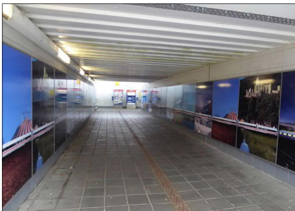
Abbildung 36: Im Bahnstunnel von Bremerhaven-Lehe wurde das Erscheinungsbild durch die Installation von Graffiti-Schutzboards mit Bahnmotiven verbessert.
