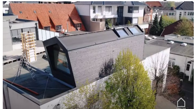
Abbildung 24: Dachaufstockung mit Cabin One (Quelle: www.youtube.com/watch?v=iJlZ64bcNuc&t=8s )
