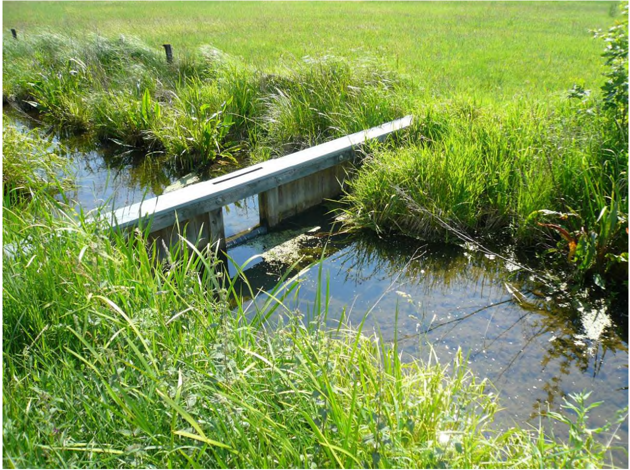
Abbildung 1: Mögliche Ausführung einer ortsüblichen Stauanlagen (Beispiel)
