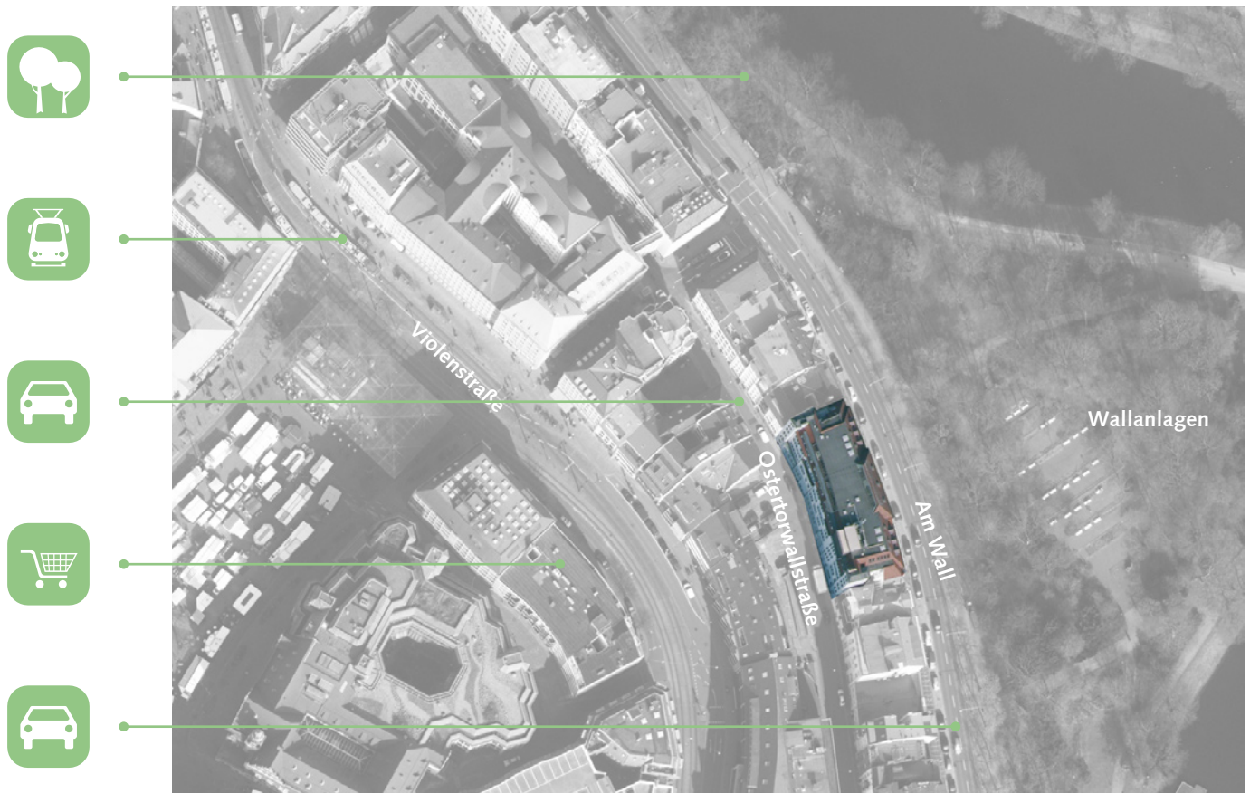
Abb. 56 Luftaufnahme Am Wall 175-177
