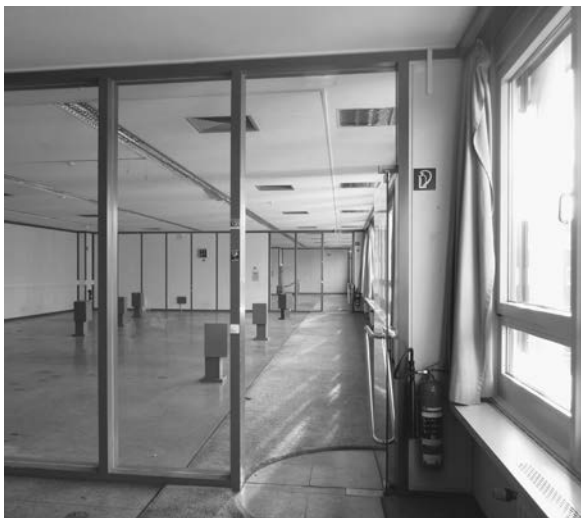
Abb. 40 Dachgeschoss - Bauteil C
