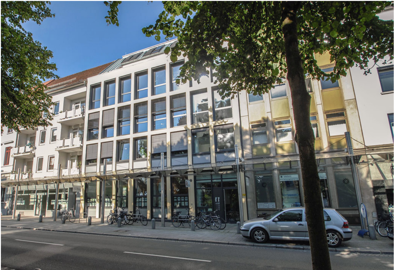
Abb. 14 Einzelhandel, Büro und Wohnen: Nutzungsmischung „Am Wall“ - Altstadt
