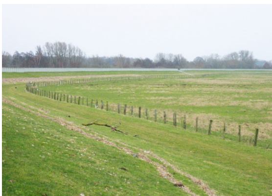
Deichbaumaßnahme Werderland in Bremerhaven: vor der Baumaßnahme
