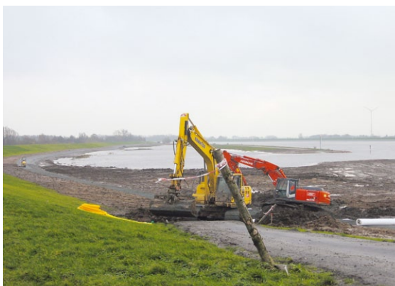
Während der Baumaßnahme
