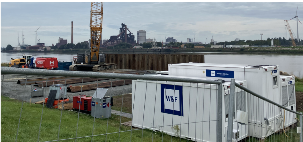
A 281 BA 4 Südseite: Spundwandarbeiten im Bereich der Weser zur Herstellung eines provisorischen Hochwasserschutzes [Sommer 2024]
