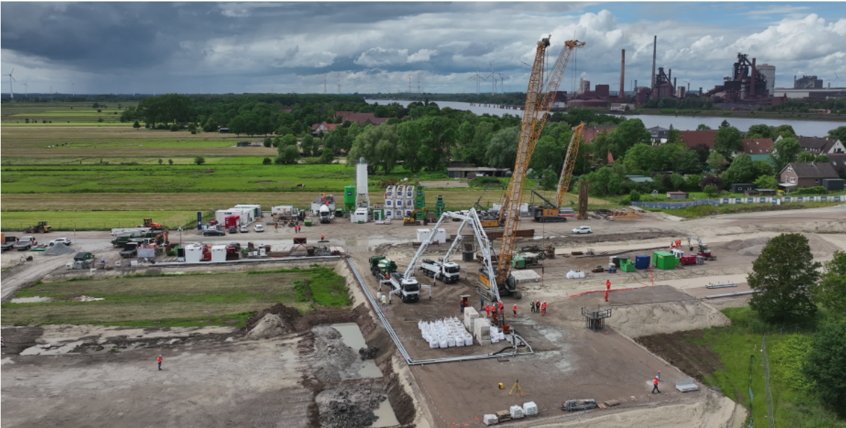
A 281 BA 4 Südseite: Baustelleneinrichtungsfläche, Vorbereitung von Schlitzwandarbeiten [Sommer 2024]
