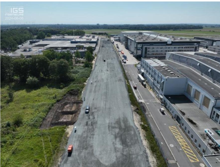
A 281 BA 2/2: Trassenvorbereitung im Bereich AIRBUS / Metro zur Umsetzung von Gründungsmaßnahmen. Hier wurde eine Arbeitsebene geschaffen, um im weiteren umfangreiche Gründungsarbeiten für Stützwände, das Brückenbauwerk und Sicht- und Lärmschutzwände durchzuführen. [Stand Juli 2024]
