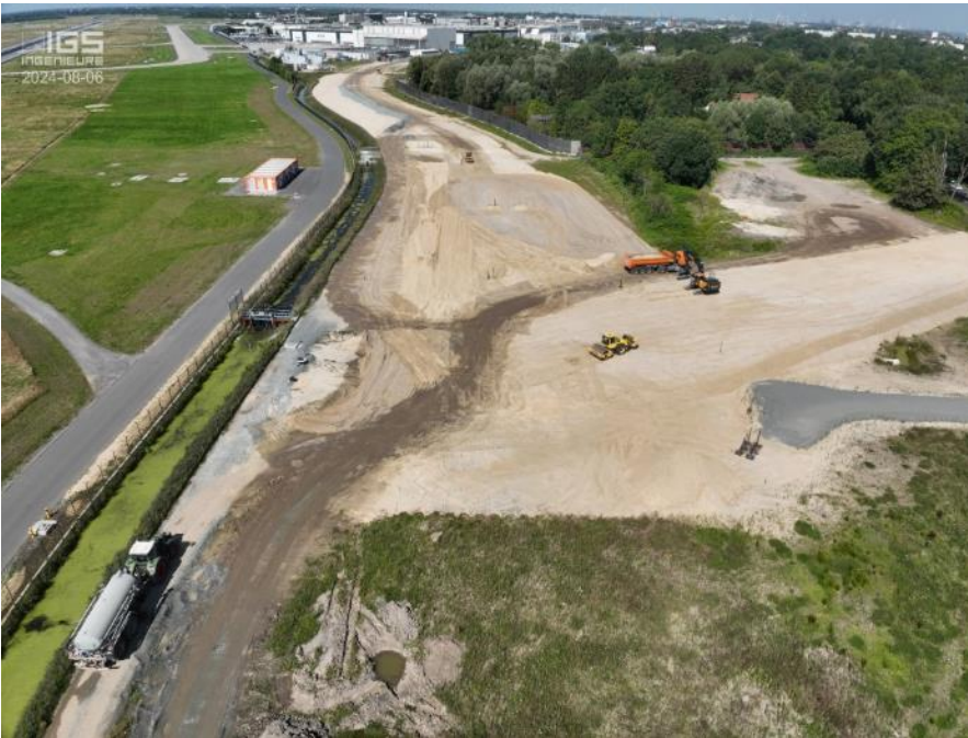
A 281 BA 2/2: Trassenvorbereitung in Randlage zum Flughafen mit Maßnahmen zur Vorbelastung des Baugrundes. Hier wird der Baugrund mit größeren Massen aus Sanden belastet, um damit ansonsten später mögliche Setzungen vorwegzunehmen. [Stand Juli 2024]
