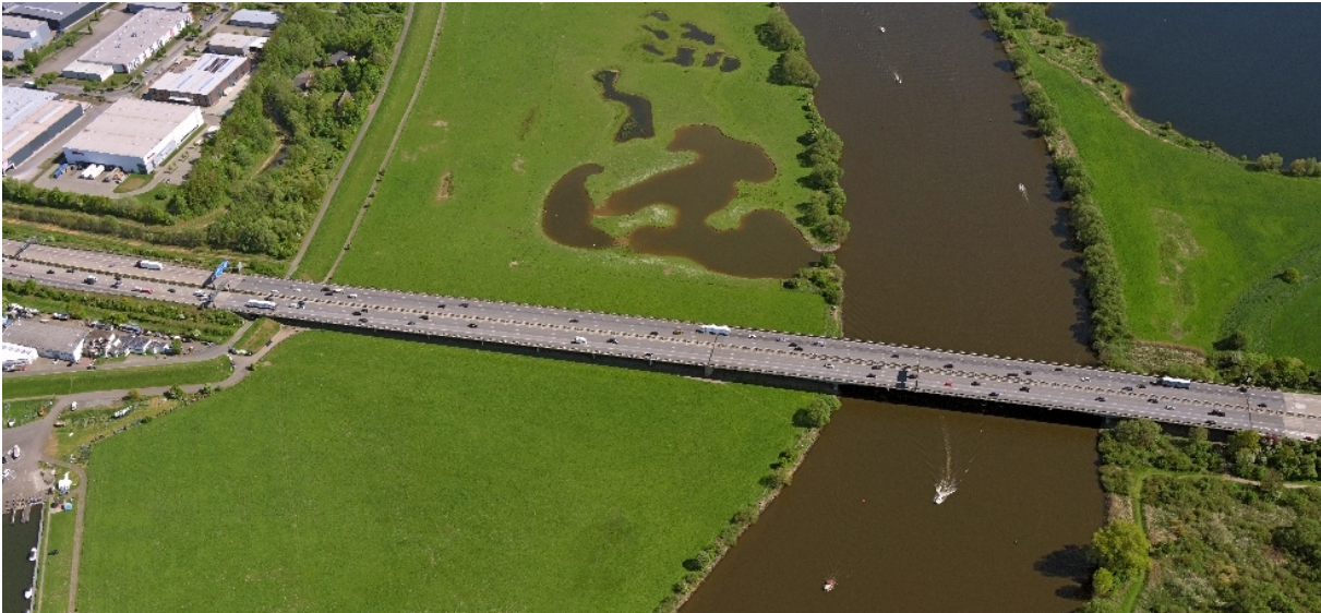
A 1 im Bereich der betroffenen Weserbrücke zwischen den beiden Anschlussstellen HB-Arsten und HB-Hemelingen [Bild Hajo Dietz, Mai 2022]
