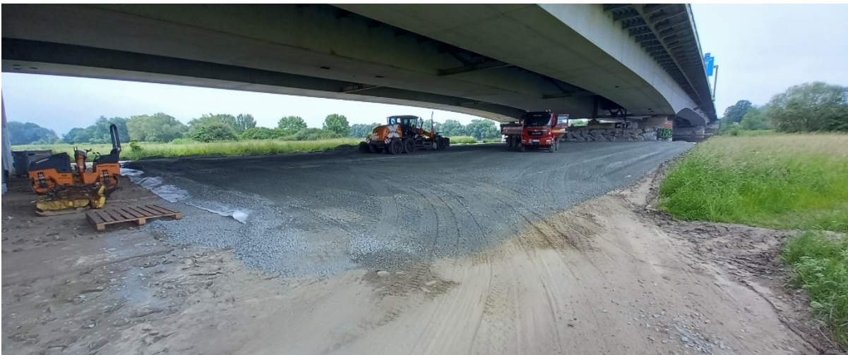
A 1 Sanierung der Weserbrücke: Baustelleneinrichtung unterhalb der Weserbrücke aus August 2024
