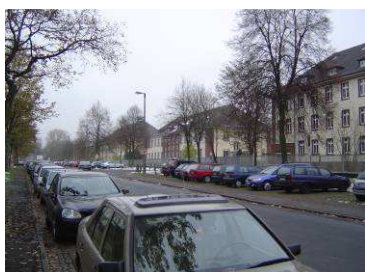
Die Scharnhorst-Kaserne am Niedersachsendamm
