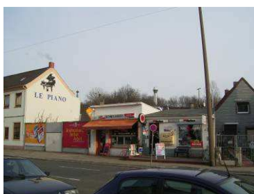
Untergenutztes Grundstück Kornstraße
