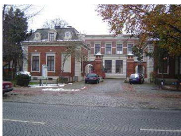
Eingangssituation Koch & Bergfeld
