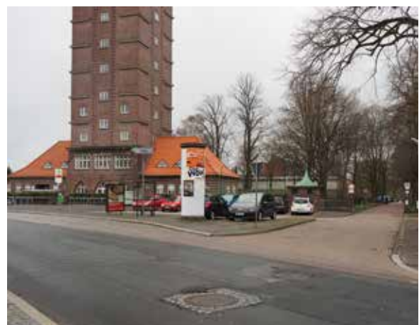
Abb. 42 Unübersichtlicher Platz vor dem Wasserturm
