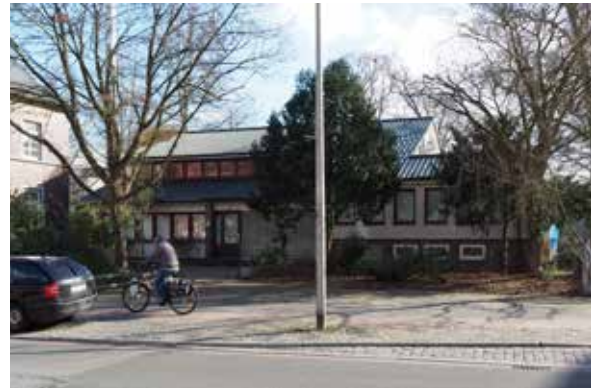
Abb. 23 Ehem. Bibliothek steht aktuell leer und erfüllt nicht die Standortanforderungen
