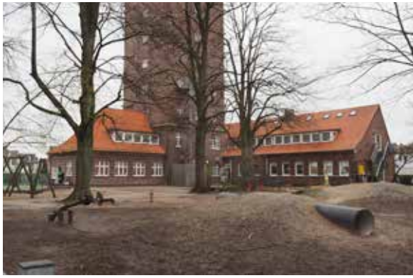
Abb. 20 KuFZ mit KiTa Wasserturm mit großem Außenbereich
