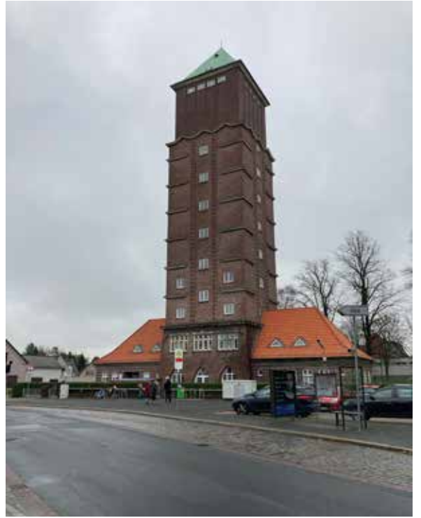
Abb. 10 Orientierungspunkt Wasserturm im Norden
