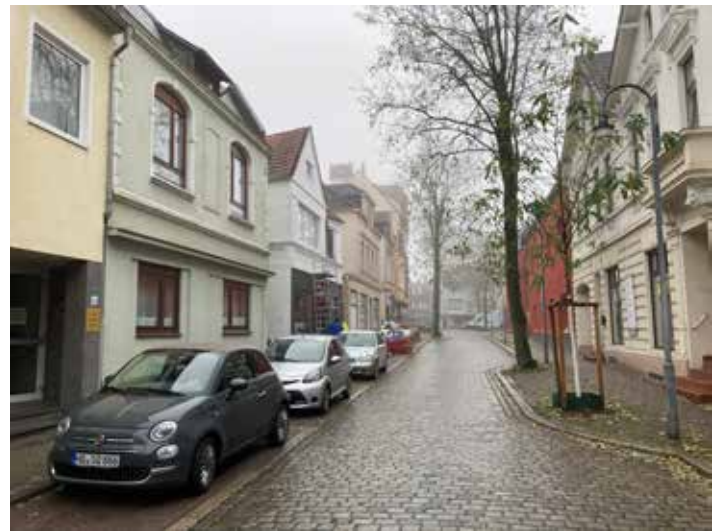
Abb. 17 Stadtbildprägender Gebäudesbestand in der Kapitän-Dallmann-Str. in unterschiedlichem Zustand
