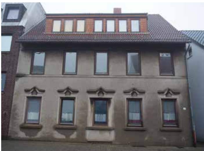
Abb. 15 Historische Gebäudesubstanz mit hohem Handlungsbedarf
