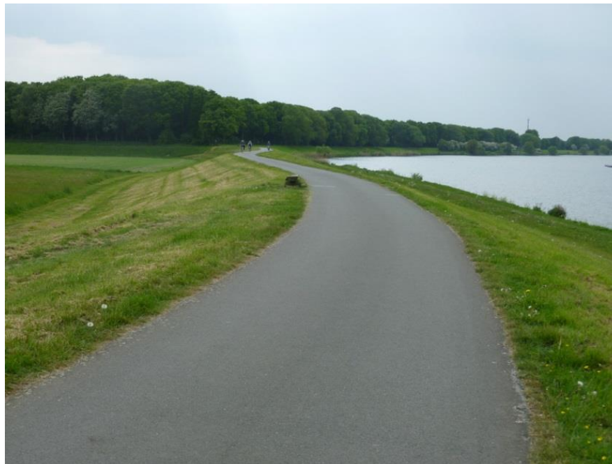
Foto des Habenhauser Deiches, in Richtung Centrum Quelle: VR 2015
