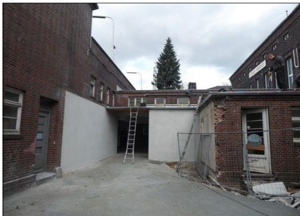
**Abbildung 2:** Der neue Seiteneingang zum Bahnsteigtunnel in Bremen-Neustadt war schon nutzbar aber noch in Bau.
