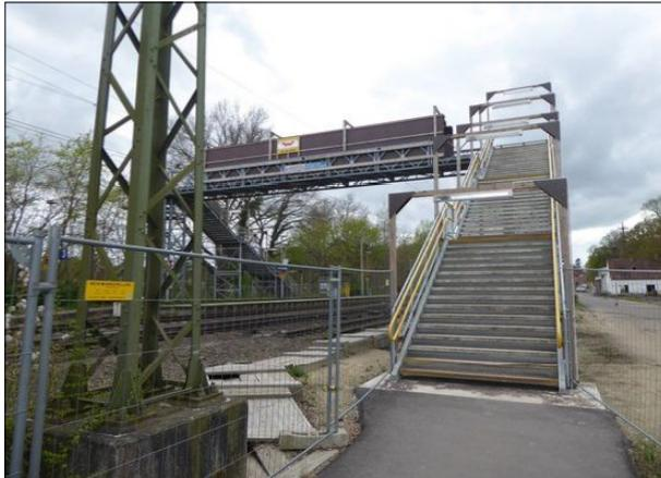
**Abbildung 4:** Während der Bauzeit für den Ersatz des Bahnübergangs durch einen Tunnel führt der Weg zwischen den Bahnsteigen in Bremen-Oberneuland über diese nicht barrierefreie provisorische Brücke.
