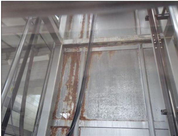
**Abbildung 35:** Die Bleche im Aufzugsschacht von Bremen-Walle sind großflächig angerostet.
