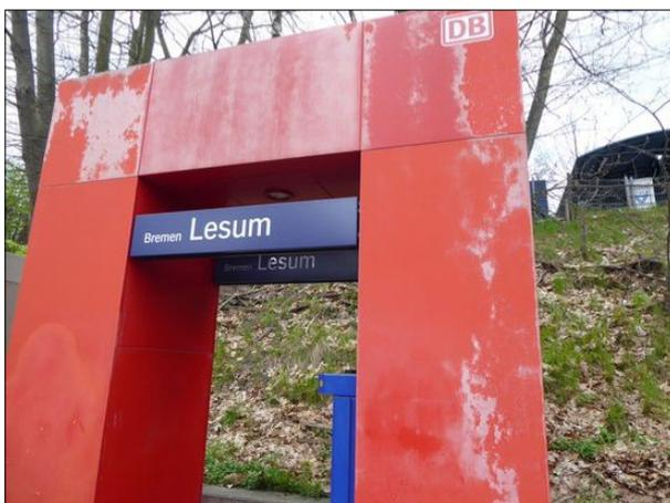
**Abbildung 45:** Die rote Farbe der Bahnsteigausstattung in Bremen-Lesum ist bereichsweise stark verblasst. Dadurch wird das Erscheinungsbild deutlich beeinträchtigt.
