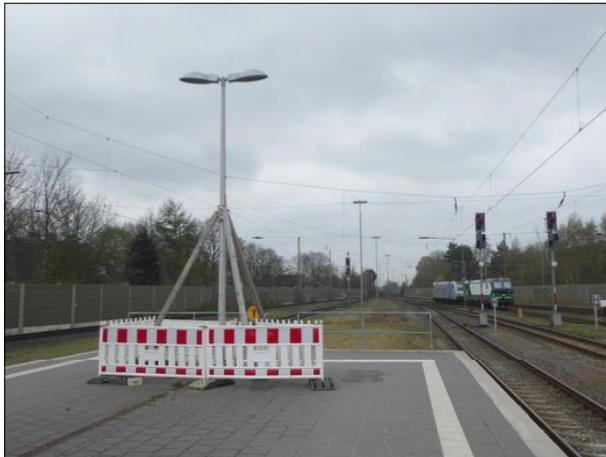
**Abbildung 50:** Bereits seit mehr als einem Jahr wird ein Lichtmast in Bremerhaven Hbf mit Holzpfählen abgestützt.
