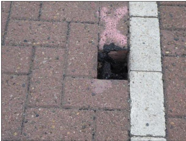
**Abbildung 8:** Dem Bahnsteig am Gleis 2 in Bremen-Oberneuland fehlte ein Pflasterstein.
