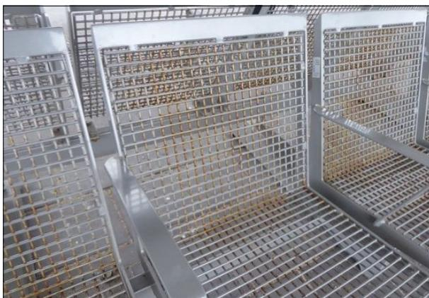
**Abbildung 12:** Auf den Bahnsteigen des Hauptbahnhofs in Bremerhaven sind einige Sitze zunehmend stark angerostet.
