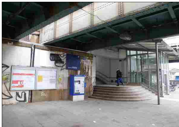
Abbildung 39: Am Zugang zum Bahnhof in Bremen-Walle beeinträchtigen zahlreiche Schmierereien und Verschmutzungen das Erscheinungsbild.
