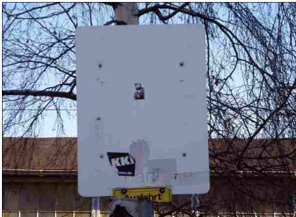
Abbildung 44: Ohne Nutzen ist diese Beschilderung am Zugang zum Bahnhof Bremen-Sebaldsbrück.
