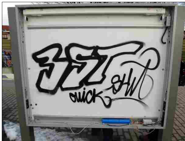
Abbildung 23: Diese Vitrine in Bremen-Walle war ohne Scheibe und ohne Leuchtstoffröhre. Die Rückwand war zudem beschmiert.
