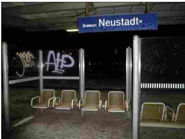
Abbildung 8: Die Windschutzwände unter dem Dach in Bremen-Neustadt waren beschmiert. Eine Scheibe fehlte. Auf den Sitzen hat sich Flugrost festgesetzt.
