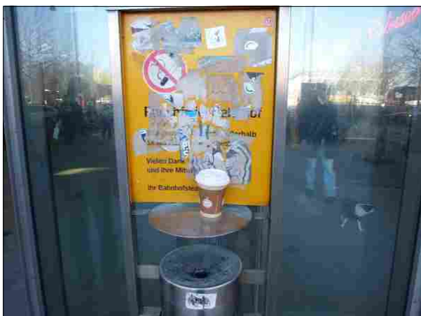
Abbildung 26: Am Zugang von der Bürgerweide in den Bremer Hauptbahnhof beeinträchtigt vor allem der Zustand der Aschenbecher das Erscheinungsbild.
