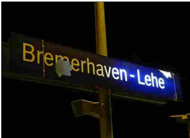
Abbildung 17: Dieses Bahnhofnamensschild war an zwei Stellen beschädigt und nur noch halb hinterleuchtet.
