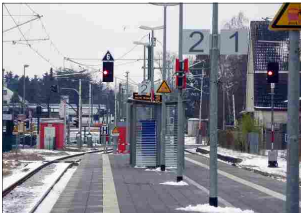
Abbildung 19: Die Information auf den Stationen der FVE mit mehreren Bahnsteigen wurde durch die Installation großer Gleisnummernschilder verbessert.
