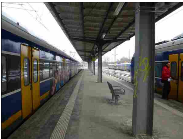
Abbildung 5: Auf dem Bahnsteig in Bremen-Vegesack wurde ein Blindenleitsystem verlegt.
