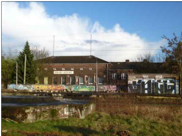
Abbildung 40: Die Bahnbauten in Bremen-Neustadt sind größtenteils mit Graffiti beschriftet.
