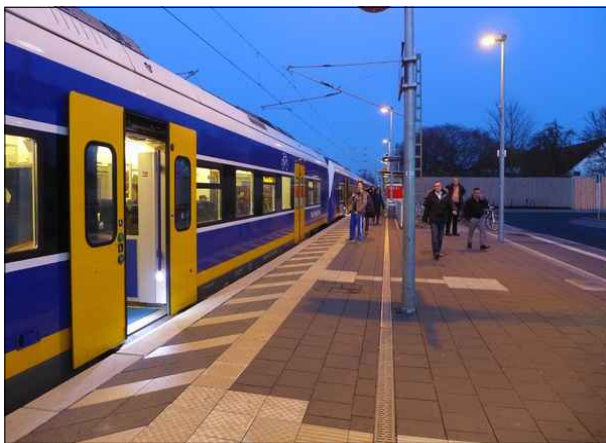
Abbildung 5: Die Bahnsteighöhe von 76 cm sorgt für einen niveaugleich Einstieg in die dort verkehrenden Züge. Zudem sichern kurze und stufenfreie Zugänge zu den seitlich angrenzenden Bus- und Straßenbahnhaltestellen eine sehr gute Verknüpfung mit den weiteren Verkehrsmitteln.
