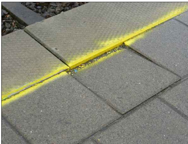
Abbildung 7: An Gleis 1 in Bremen-Schönebeck gibt es stellenweise kleine Absackungen mit Stufenbildung.
