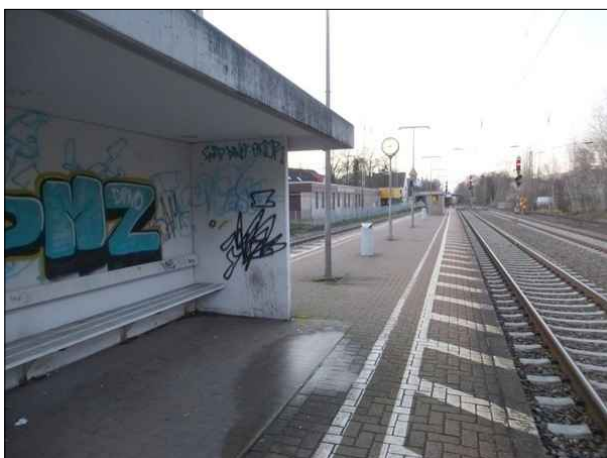
Abbildung 45: Die Betonunterstände in Bremen-Hemelingen werden immer wieder beschmiert. Bis zur geplanten Verlegung der Station wird sich daran vermutlich nichts ändern.
