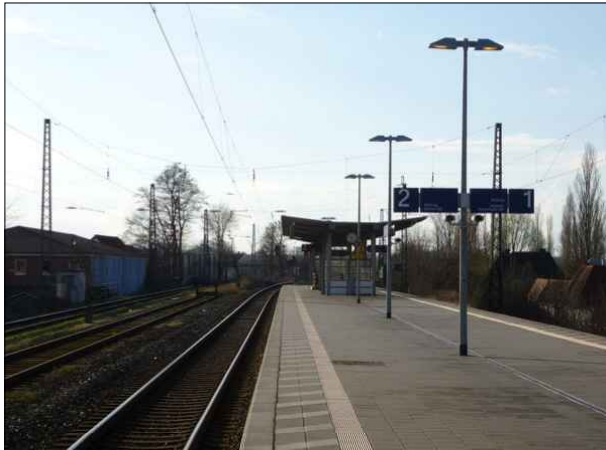
Abbildung 37: Auf dem Bahnsteig in Bremen-Oslebshausen war die Beleuchtung tagsüber eingeschaltet.
