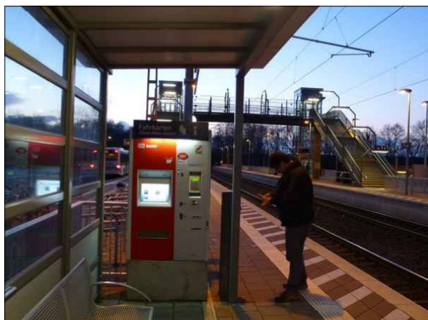
Abbildung 11: Durch die fehlende Verkleidung rund um den neuen Automaten ist der Wetterschutz dieses Unterstands in Bremen-Mahndorf etwas eingeschränkt.
