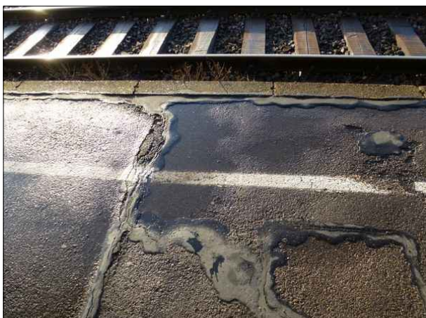
Abbildung 9: Die Oberfläche des Bahnsteigs in Bremen-Neustadt weist trotz zahlreicher Ausbesserungen fast flächendeckend Unebenheiten mit Pfützenbildung auf.
