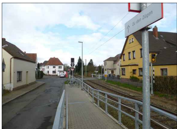
Abbildung 24: Die Montage parallel zum Gleis ist für den Nutzen der Schilder „Zu den Zügen“ in Bremen Mühlenstraße sehr ungünstig.
