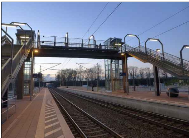
Abbildung 4: Der Bahnhof Bremen-Mahndorf wurde barrierefrei errichtet. Eine Personenüberführung mit Treppen und Aufzügen ermöglicht allen Fahrgästen eine gute Erreichbarkeit der Bahnsteige.
