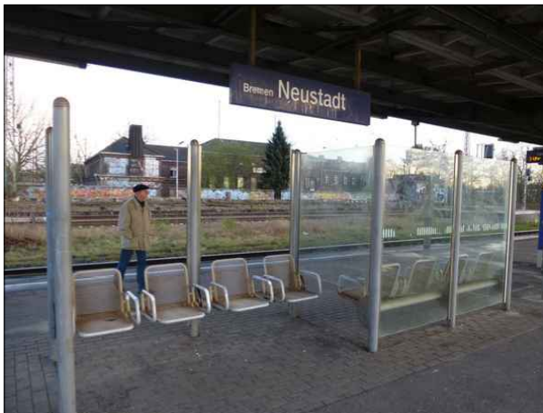
Abbildung 47: Die fehlenden Scheiben im Windschutz von Bremen-Neustadt tragen zur unbefriedigenden Qualität des Bahnhofs bei.
